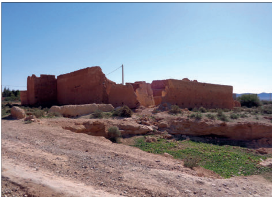
Figura 13. Exterior del puesto de Abeino, desde el noroeste
