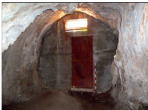
Figura 8. Cueva de Las Mestas: entrada suroeste desde el interior, cegada con muro de hormigón, puerta metálica y rejilla de ventilación.
