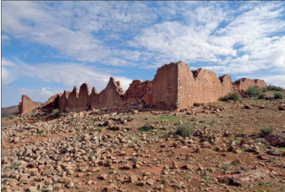
Figura 7. Muro exterior norte de Tiguist Igourramen, desde el noroeste
