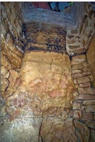
Figura 7. Palacio episcopal, pozo de la crujía norte. Particular de uno de los laterales, conformado por la combinación de aparejo de bloques y un frente labrado sobre el substrato calizo.
