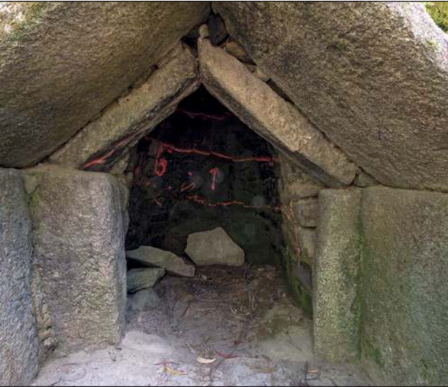
Figura 6. Cubierta en mitra en la cámara y boca del horno de Pena Grande.
