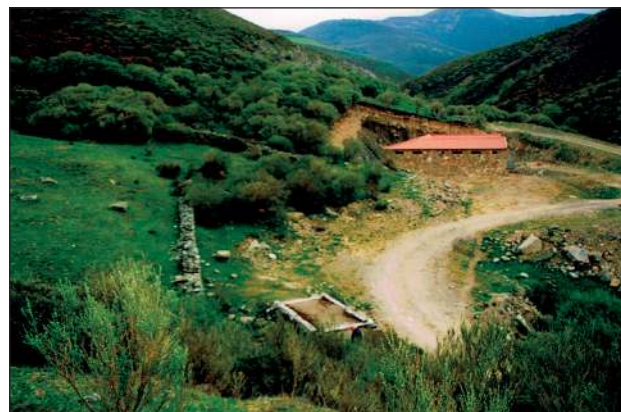
Figura 2. Vista similar a la anterior en el año 2005, donde se aprecia la alteración provocada por la apertura de la pista y la construcción de la nave ganadera.
