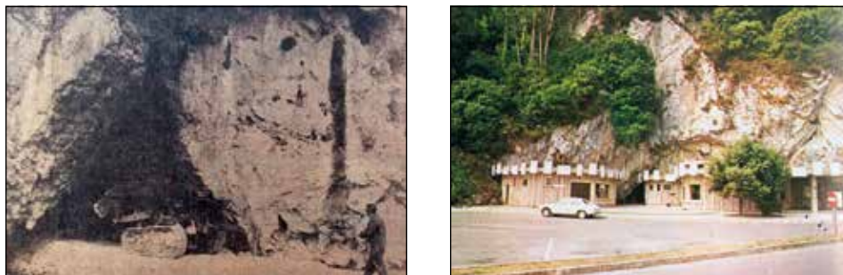
Figura 4. A la izquierda, obras de apertura del túnel artificial de Tito Bustillo. Archivo de la Nueva España. A la derecha, primeras instalaciones de acceso a Tito Bustillo, inauguradas en 1972. Silverio Cañada.
