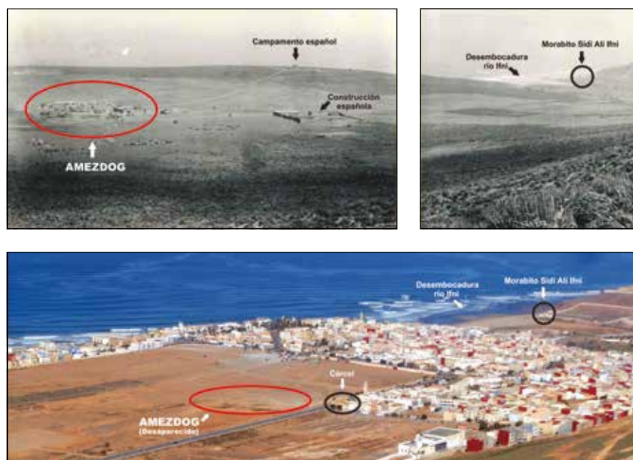
Figura 20. Arriba: imagen de 1934, tomada desde el sureste, desde la ladera del monte Bulaalam, en la que señalamos el poblado de Amezdog, a la izquierda, y el campamento español, al fondo. Se aprecia la construcción española separada del poblado («Vista panorámica de Ifni (Marruecos)», Archivo General Militar de Madrid, con signatura F.09370, disponible en la Biblioteca Virtual de Defensa). Abajo: fotografía de 2024 con la misma vista, en la que se sitúa el espacio del desaparecido Amezdog (autor).
