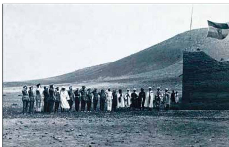
Figura 7. Arriba: vista aérea del aduar o poblado de Amezdog a principios de abril de 1934, tomada desde el oeste, en la que se aprecian sus construcciones y se señala la edificación en la que se instaló la Comandancia española (Dirección de Aeronáutica, en AHORA 1934:16). Abajo: imagen del izado de la bandera española de la época (IIª República) en la edificación de la Comandancia, vista desde el suroeste (López Garro 1934:1).
