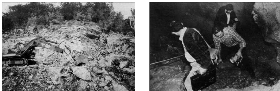
Figura 18. A la izquierda, obras de la carretera en el entorno de La Covaciella. A la derecha, visita de inspección en el interior de la cavidad. Archivo El Comercio.
