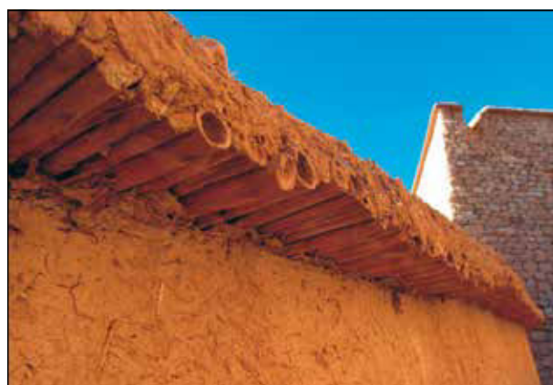
Figura 22. Arriba: cubierta interior de cañizo en el viejo fuerte francés de Aouinet Torkoz, cerca de la margen derecha del bajo río Drâa, construido utilizando técnicas y materiales locales. Abajo: detalle exterior de la cubierta de cañizo en una de las edificaciones de la Kashba de Ait Ben Haddou, al pie de la vertiente sur de las montañas del Atlas (autor).
