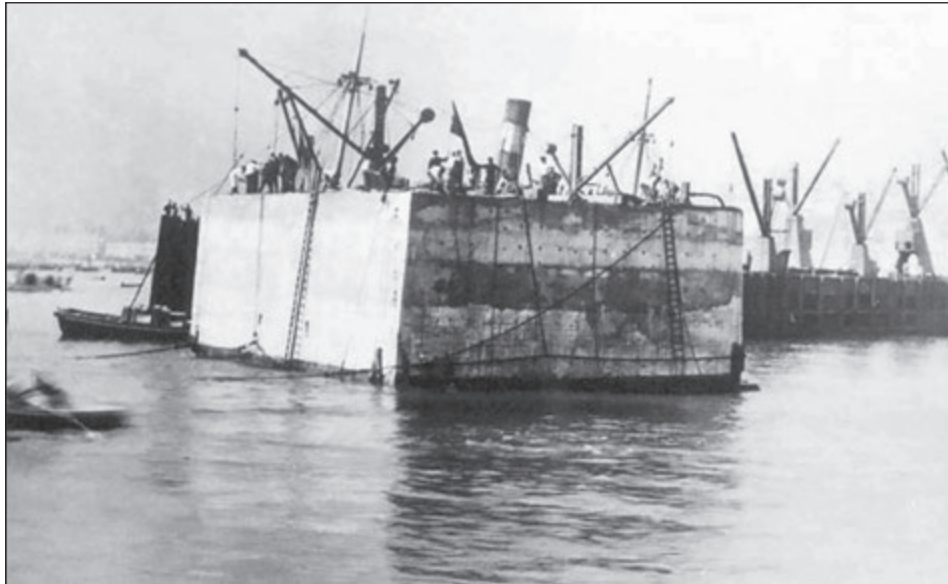
Figura 15. Monolito o cajón de hormigón armado del Puerto de Valparaíso en 1917, durante su traslado a su ubicación definitiva (Memoria Visual del Puerto de Valparaíso, en Cavieres 2011:XIX).
