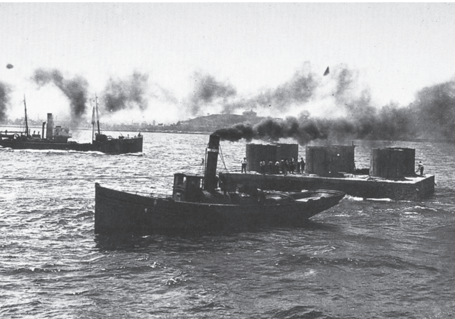
Figura 18. Remolque de uno de los cajones de hormigón en la ampliación del dique norte del Puerto de Gijón en los años 30. En: https://vidamaritima.com/2008/05/ferrocemento-concrete-ships-barcos-y-puertos/ [Consultado: 24.09.2023].
