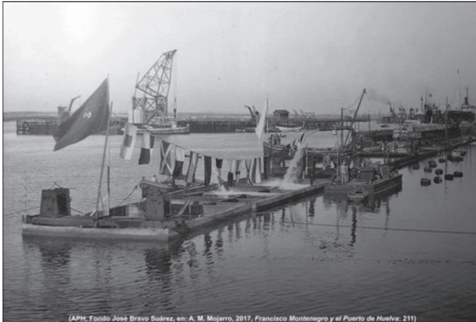
Figura 17. Hundimiento del primer tramo de cajones de hormigón del Muelle de Levante del Puerto de Huelva (APH, Fondo José Bravo Suárez, en Mojarro 2017:211).
