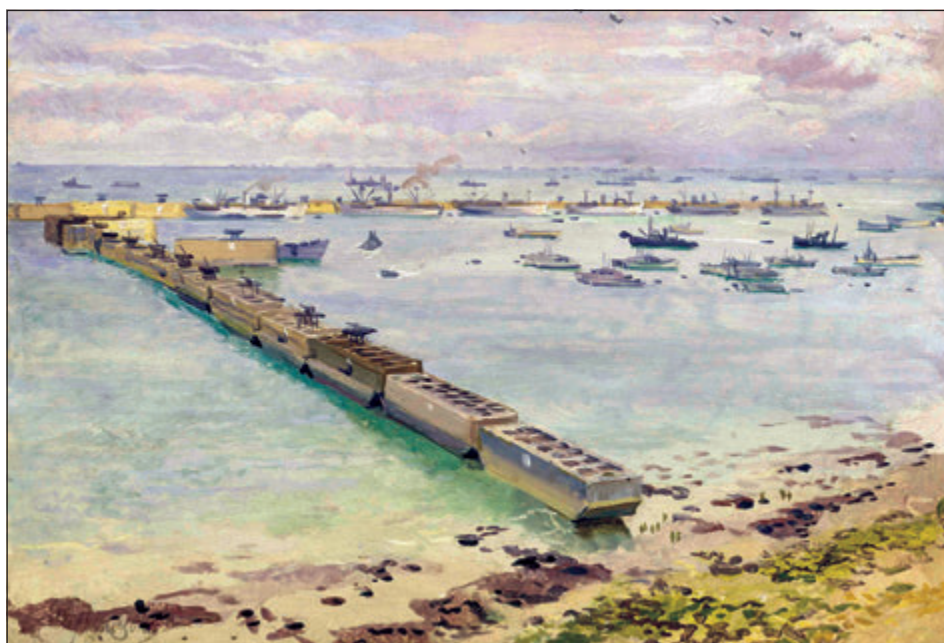
Figura 20. Aspecto de un Mulberry en funcionamiento, plasmado por Stephen Bone, hijo de Sir Muirhead Bone, en el que se aprecian las barcazas/Phoenix perfectamente alineadas, configurando un rompeolas ( Royal Museum Greenwich ).
