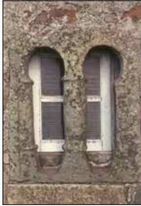
Figura 7. San Martín de L'Aspra. Ventana bífora.
