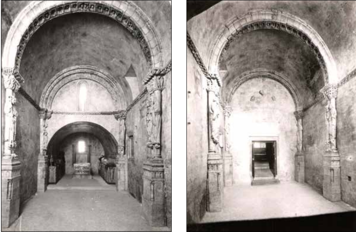
Figura 17. Aspecto de la Cámara Santa en 1941, después de la intervención. Archivo de Pedro Díaz Gómez de los Fondos de la catedral de Oviedo.
