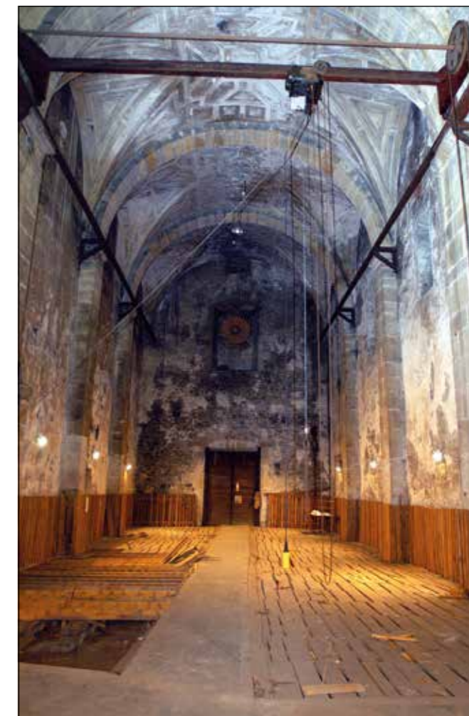
Figura 2. Nave central de la iglesia convertida en almacén de tabaco.
