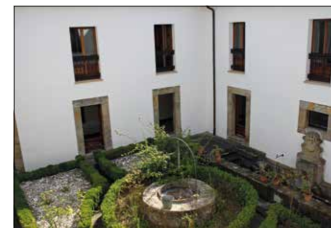
Figura 5. El pozo ocupa el espacio central ajardinado del claustro, mientras que la fuente lavadero fue adosada al lienzo sur. Destaca la sencillez y austeridad de todo el conjunto.
