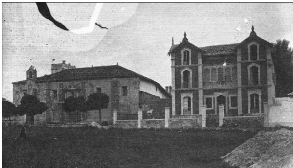
Figura 15. Vista desde el este del edificio conventual a principios del siglo XX. Al fondo del recinto claustral, en la esquina noroeste, se aprecian las chimeneas de la cocina (García Fernández 1989:61).
