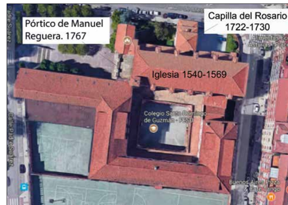
Figura 1. Fotografía aérea de la planta actual.
