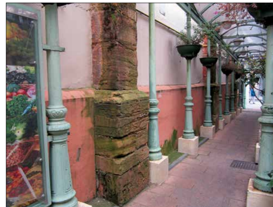
Fig. 11. Vista del alzado lateral norte de los vestigios de la Escuela de María. Se conservan tres contrafuertes, dos posibles ventanas de medio punto, y la esquina nordeste del edificio.
