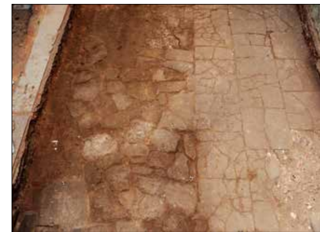
Figura 7. Suelo original de la panda occidental del claustro del convento.
