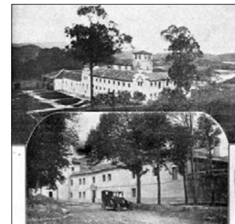
Figura 7. Monasterio de Celorio. Arriba, vista general; abajo, portería del edificio y plaza de la casa rectoral. Páginas escolares, 18, marzo 1922:11.
