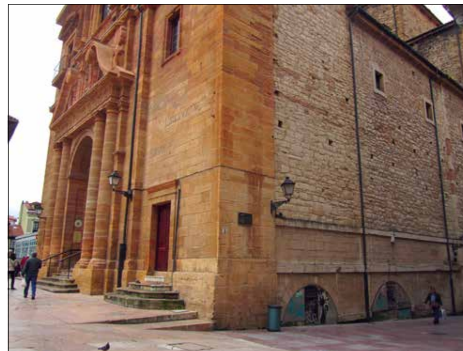
Fig. 10. Vista del alzado lateral norte del templo. Se aprecian los cambios de aparejo correspondientes a las diferentes fases constructivas del templo, así como los dos arcos de medio punto que alojaban sendas tiendas.
