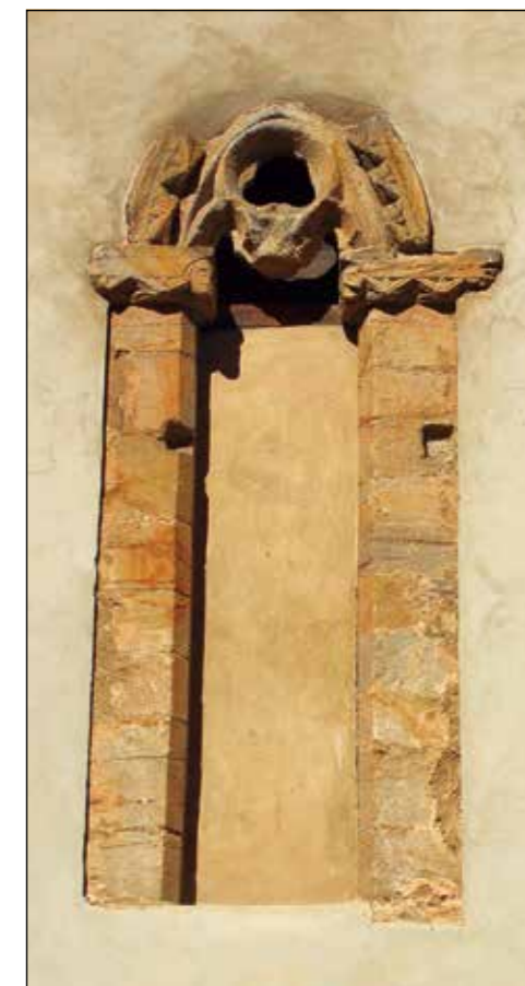
Figura 4. Ventana en el muro sureste de la iglesia. Se aprecian dos entalles en las jambas para el asiento del techo del corredor del claustro. La falta del remate superior del arco también puede estar en relación con la sujeción de la cubierta del mismo.
