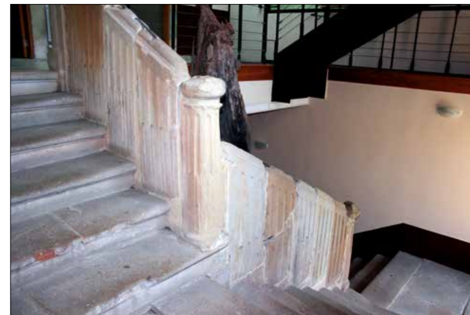
Figura 4. Escalera de antepecho acanalado, conservada en la crujía este del monasterio.
