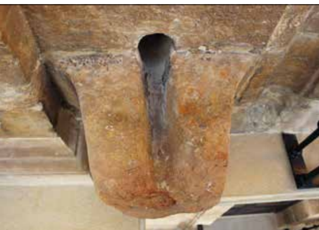
Figura 20a. Vista de los alzados sur y oeste del interior del claustro con algunos de los desagües conservados señalados en rojo. Figura 20b. Detalle de uno de ellos.
