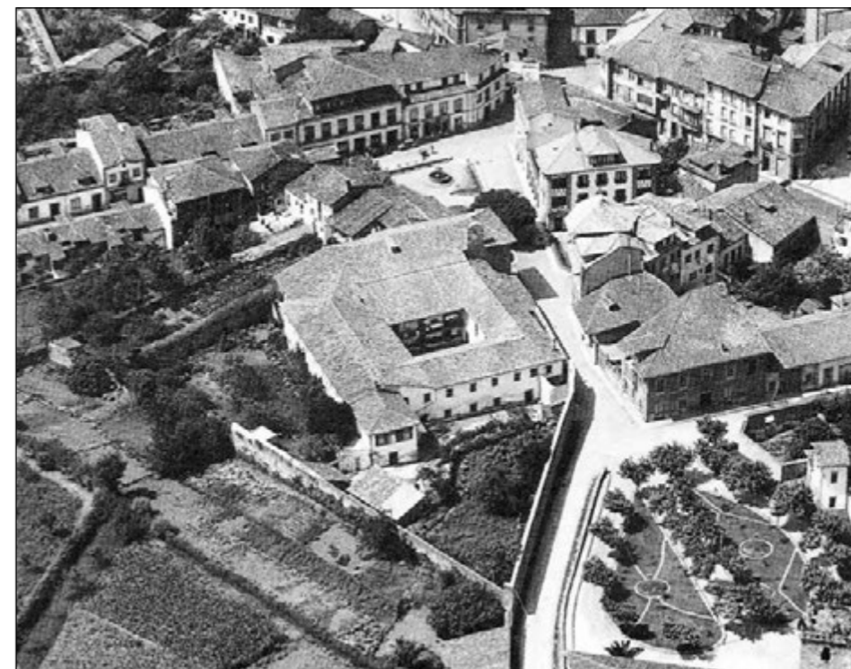
Figura 3. Vista aérea desde el sur de Villaviciosa tomada en el año 1961. Detalle del convento de Santa Clara (Pedrayes 1994:279). En esta imagen se aprecia la desaparición de la zona abuhardillada sobre la crujía norte, que resulta claramente reconocible en la Figura 2.
