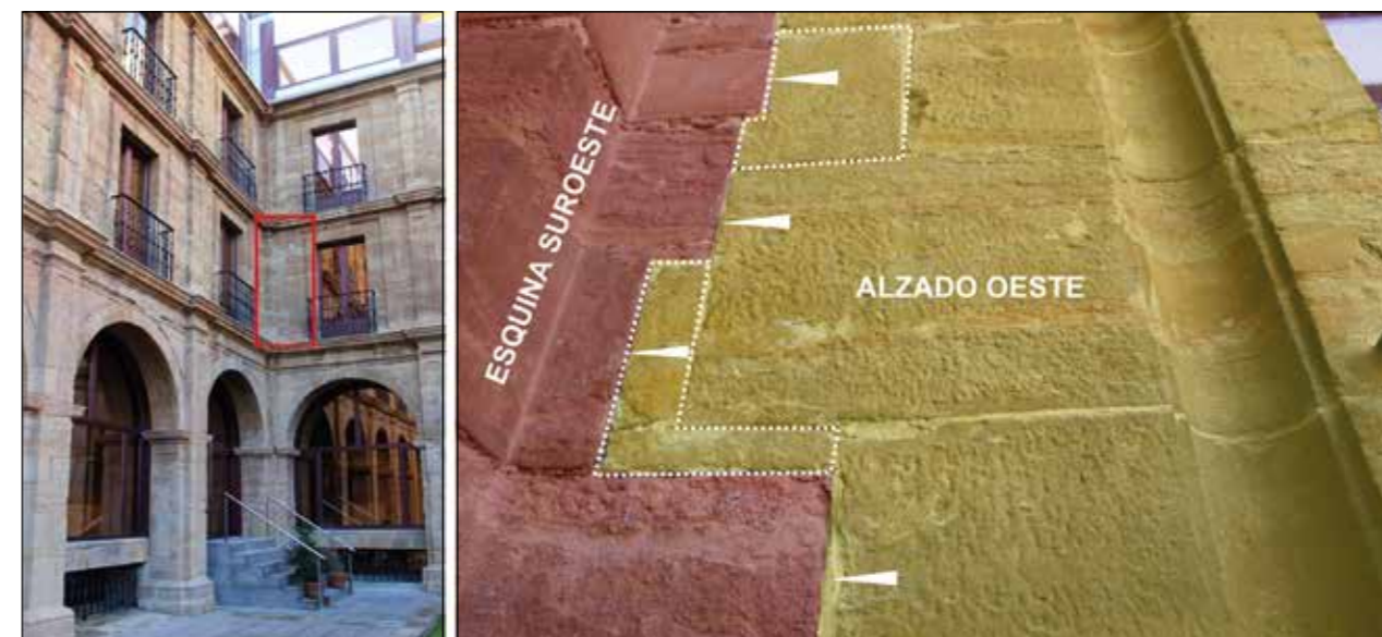
Figura 11. Detalle de la esquina suroccidental del claustro. Se observa como el lienzo occidental (en amarillo) se adosa a la esquina suroeste, que presenta uniformidad constructiva con el alzado sur (en rojo). Se aprecia la adaptación a los huecos resultantes en la talla de los sillares que sirven de unión (en línea de puntos).
