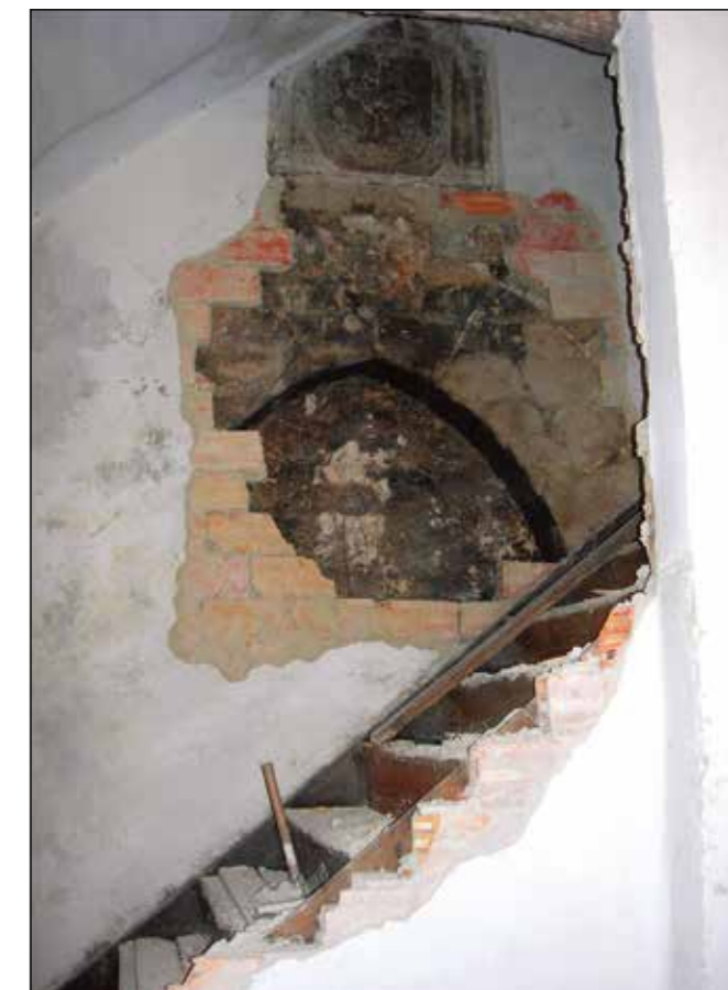
Figura 7. Fachada del palacio franciscano del siglo XV, localizada tras el tabique de ladrillos que la ocultaba.
