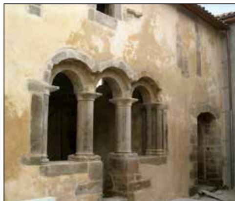
Figura 5. Arquería de la sala capitular. El capítulo fue construido a principios del siglo XV, de forma que su muro oeste constituye un mismo paño con el imafrente de la iglesia y el palacio de los González de Oviedo.
