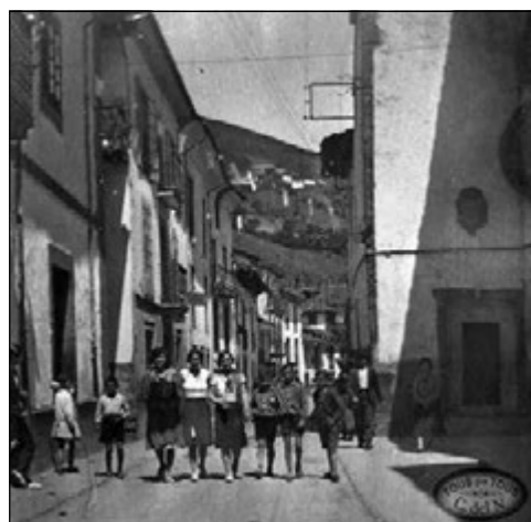
Figura 5. Puerta de la portería, ubicada en la esquina noroeste del edificio conventual. Fuente: www.touspatous.es .
