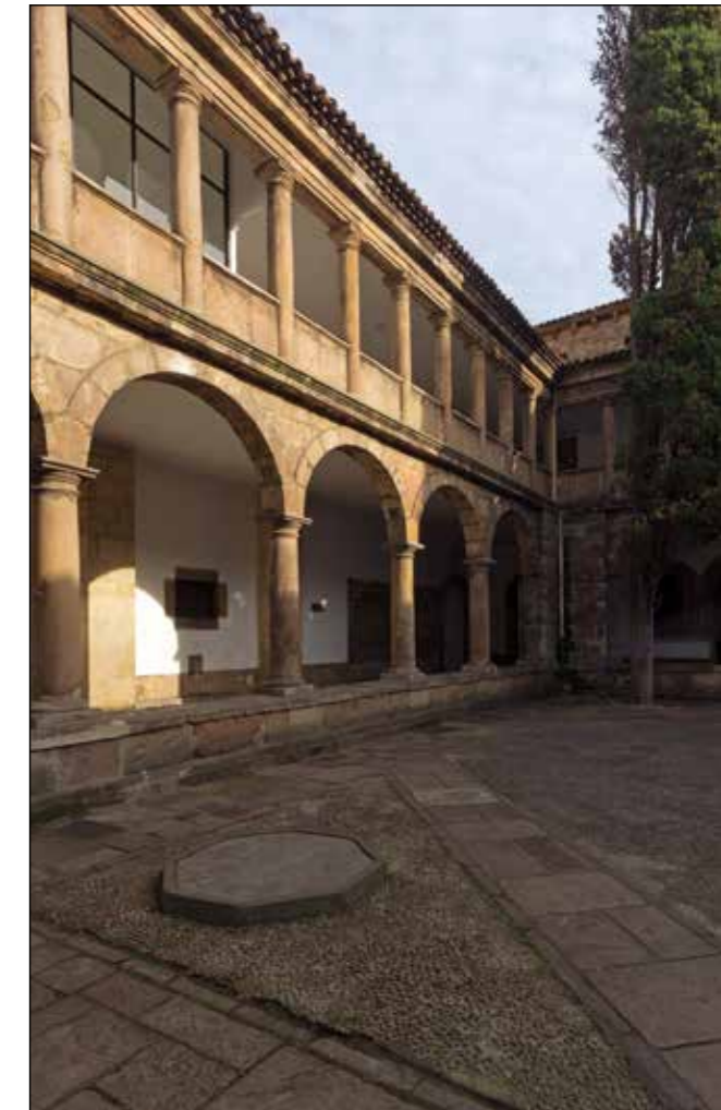
Figura 5. Claustro. Estado actual.
