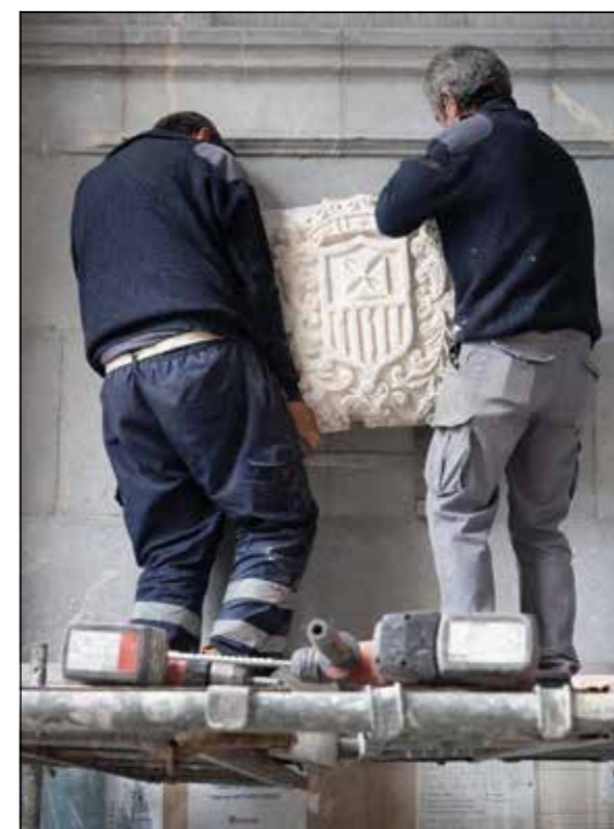
Figura 6. Colocación del antiguo escudo del convento de La Merced durante las obras de restauración de la iglesia de Santo Tomás de Sabugo. Fotografía: Omar Antuña. La Voz de Avilés. 16/05/2020
