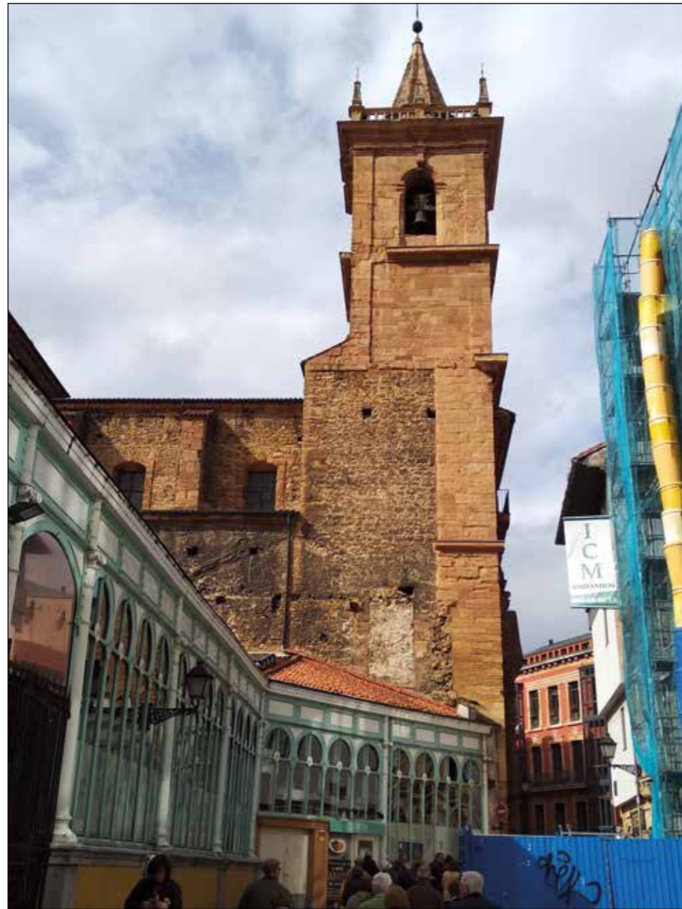
Fig. 12. Vista del alzado lateral sur del templo. En primer término se localiza la plaza de abastos construida en 1882, y detrás, en el paramento de la iglesia, se observa la huella del tejado del antiguo colegio demolido, y la puerta cegada que servía de paso entre éste y la tribuna del templo.
