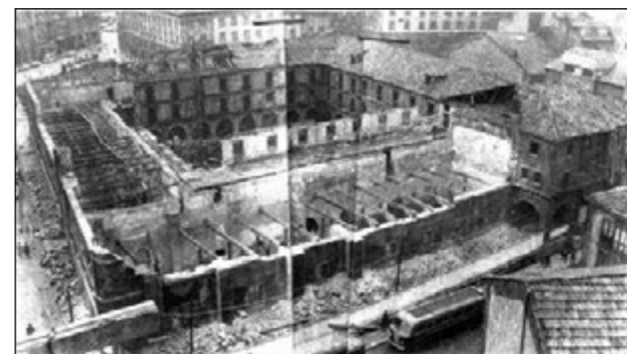
Figura 3. Fotografía de Ramón Álvarez-Borbolla tomada durante el derribo del antiguo convento de Santa Clara, donde puede verse parte del interior de la iglesia y los contrafuertes exteriores. Publicada el 6 de noviembre de 2015 por «T Oviedo» ( www.facebook.com/oviedoES ).
