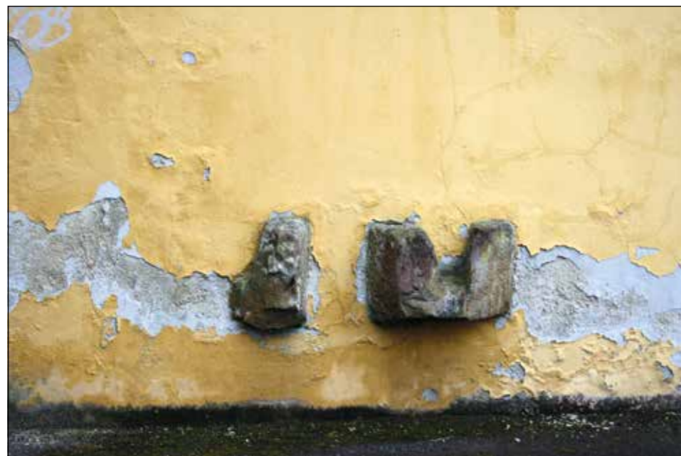
Figura 7. Conducciones de piedra conservadas en la fachada este de la sacristía anexa a la iglesia monacal de San Juan de Capistrano.
