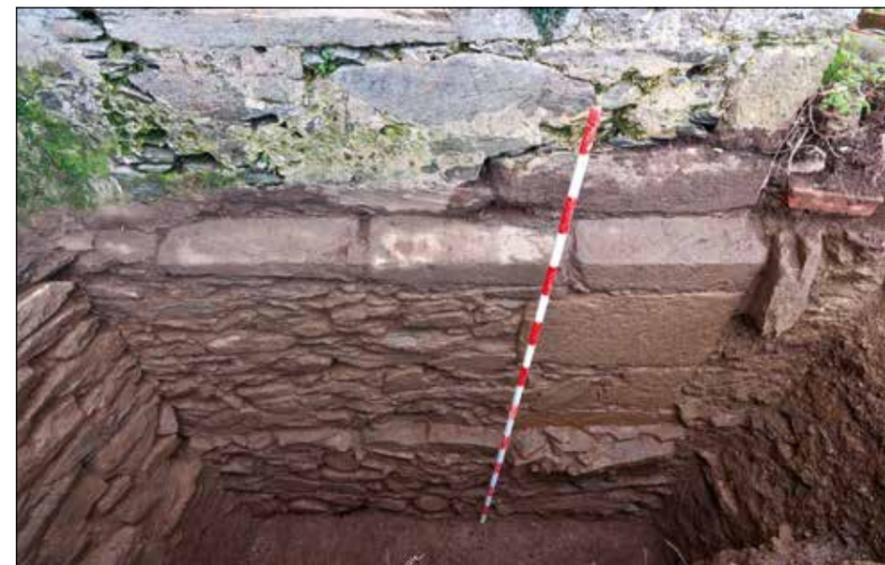
Figura 10. Sondeo abierto al norte de la iglesia en 2013. En el frente se puede ver el z calo de la capilla norte, hoy en d a completamente soterrado. A la izquierda, la cimentaci n de la sacrist a, cuya base se dispone a nivel con la pesta a de la cimentaci n de la capilla. Foto: los autores
