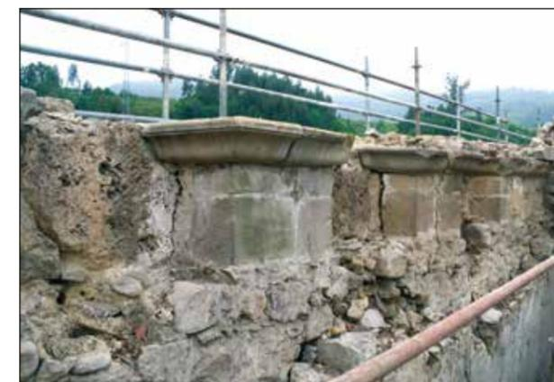
Figura 7. Vista lateral de los machones de cantería con las molduras de tipo gola que se conservan en el tramo superior del cerramiento meridional de la torre situada en la esquina sudeste del recinto claustral.
