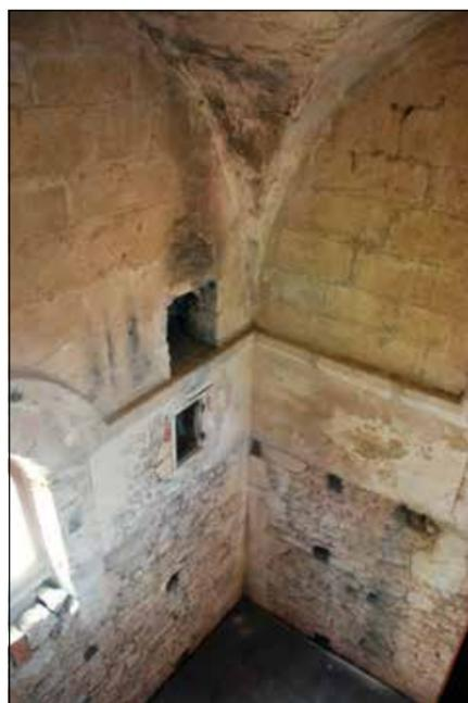
Figura 4. Torre. Interior, cambio de fábrica entre el piso segundo y el tercero. Fotografía de los autores.
