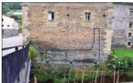
Figura 8. Fotointerpretación con la hipótesis de la cámara de evacuación en el interior del muro que cae al río, desde el sureste.
