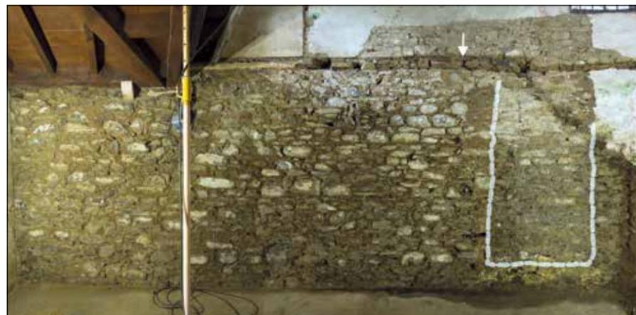
Figura 9. Pared norte del cabildo occidental. En l nea discontinua, la antigua puerta de acceso hoy cegada. La flecha se ala el nivel exterior del terreno en la actualidad. Foto: los autores
