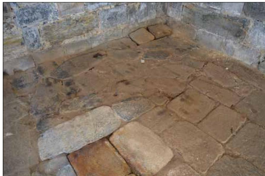
Figura 9. Antiguo podio de la pila bautismal, recortado por una reforma del pavimento en la esquina sudoeste del templo.
