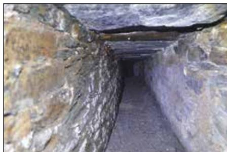
Figura 7. Vista del canal-alcantarilla con cubierta de grandes losas de pizarra (arriba), y detalle de su interior (abajo).
