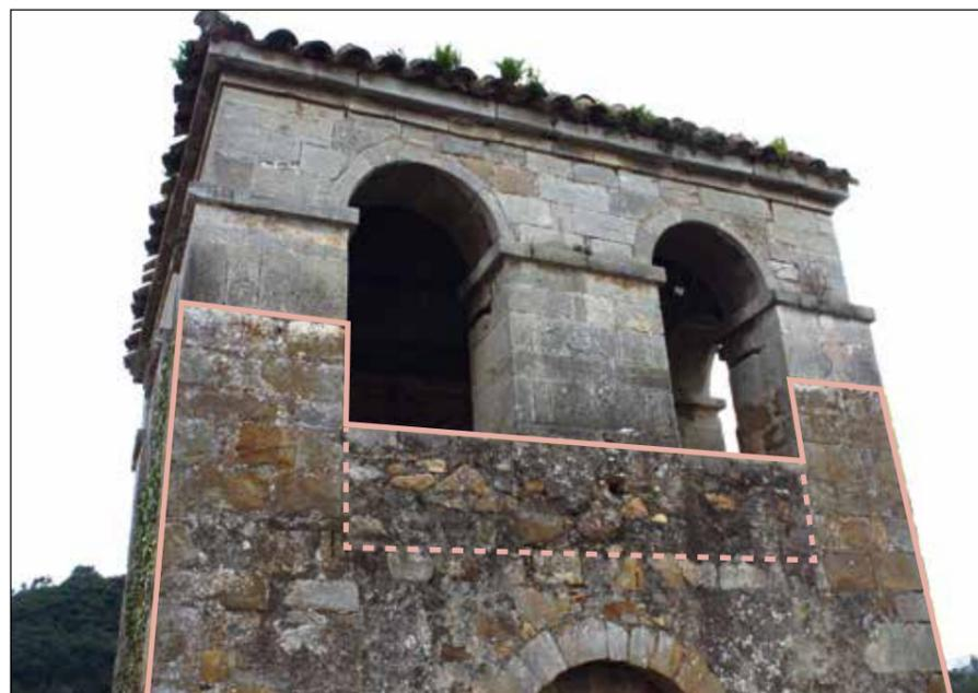
Figura 6. Vista del alzado occidental de la primera torre medieval a la que se adosa el templo. Se aprecia como el remate del siglo XVII se superpone sobre un cuerpo inferior en el que se advierte un primitivo remate almenado, del cual se conservan las almenas machones situadas en las esquinas. Este remate almenado presenta además un pequeño retranqueo frente a la fábrica inferior románica sobre la cual se levanta.
