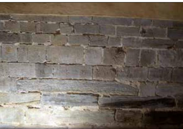
Figura 5. Vista del alzado interior del cerramiento meridional del templo. Se aprecian tres fábricas superpuestas: la inferior con aparejo de bloques alargados; la intermedia con sillaría y numerosas marcas de cantero; y la superior, revocada, con fábrica de mampostería.
