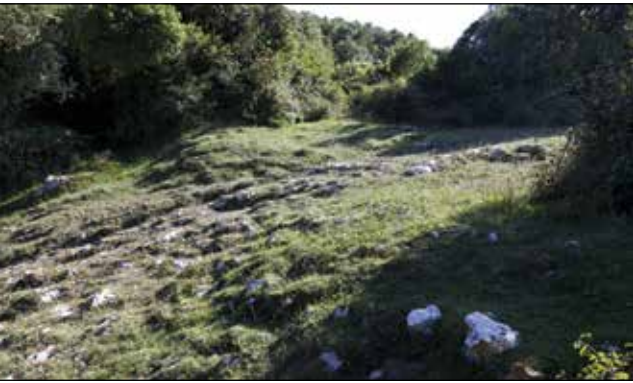
Figura 4. La parte del parapeto intervenida antes del comienzo de la actuación.
