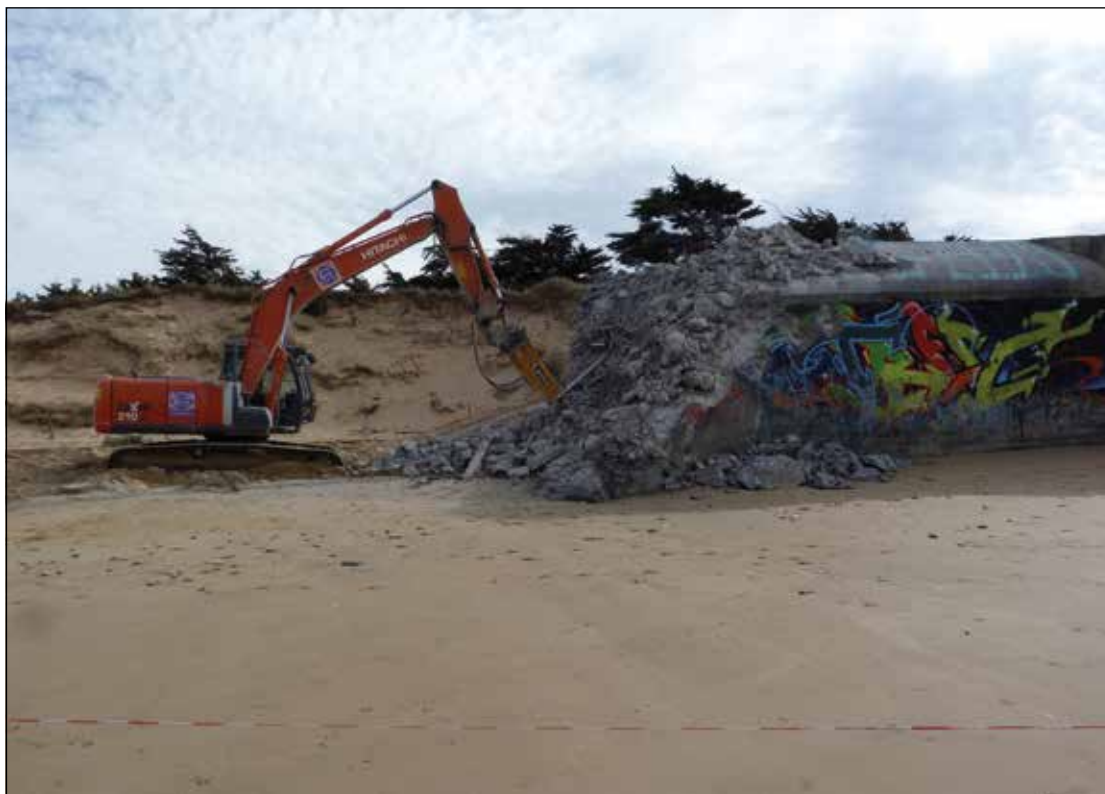
Figura 16. Maquinaria pesada realizando los trabajos de demolición de una de las casamatas artilleras dobles de la batería Klara en septiembre de 2016. El hormigón de los escombros se reutilizará como material de relleno en el dique de Doreaux en la población de Saint-Clement-des-Baleines, dentro del programa de prevención de inundaciones (fotografía de Jean-Luc Moser).
