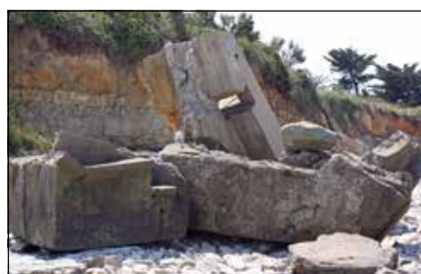
Figura 27. Sistema de túneles. 27a: Imagen de uno de los tramos de pasillos subterráneos de la posición. 27b: Fotografía que muestra el resultado de la erosión marina en el acantilado y en las estructuras de la batería. Son visibles dos entradas al complejo subterráneo, además este proceso erosivo permite observar la estratigrafía de la zona y los depósitos de la excavación de los muros. 27c: Otro ejemplo de la destrucción causada por la erosión del terreno, una de las plataformas artilleras yace en el fondo del acantilado, su estructura de hormigón armado rota en diferentes fragmentos permite observar determinados detalles constructivos que en circunstancias normales no serían visibles, como la cimentación de la misma (fotografías autor).
