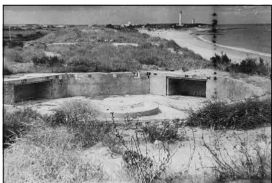
Figura 32. Imagen de una de las dos posiciones antiaéreas de Klara, de perfil exterior cuadrado y forma octogonal en el interior, con una plataforma de tiro circular. Al fondo se pueden ver los dos faros de la punta de Baleines (SHM Rochefort 1W 1849).
