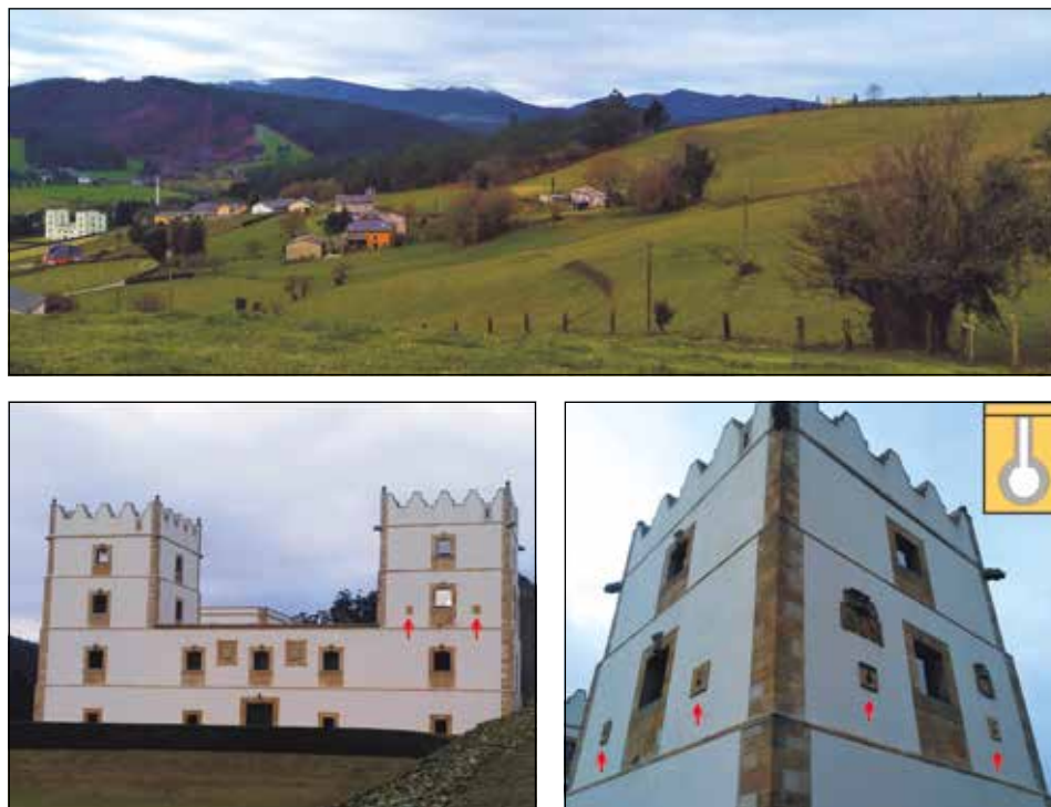
Figura 4. En la imagen superior se aprecia la posición topográfica que ocupa el Palacio de Anleo con respecto a la ladera de la colina donde se encuentra el topónimo Las Penas . Abajo a la izquierda, vista de la fachada principal del palacio. Abajo a la derecha vista parcial de la torre septentrional donde se reconocen 4 troneras artilleras de «palo y orbe».
