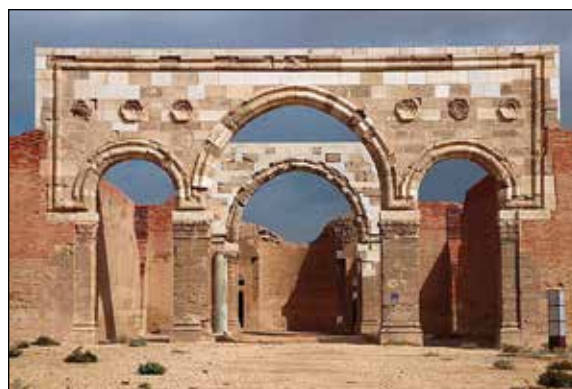
Figura 26. A. Qal'at Sim'an, vista desde la fachada meridional. B. Qasr al-Mshatta, puerta de entrada triarcada que lleva a la estructura basilical, después de su restauración por la Universidad Técnica de Berlín en 2012 (Foto disponible en: www.smb.museum ).
