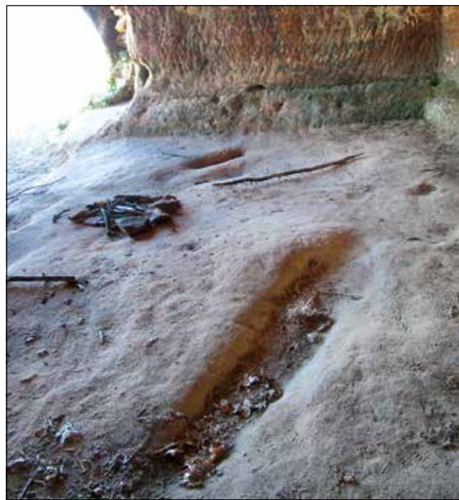
Figura 7. Desperfectos y restos de vandalismo en la iglesia de San Martín.
