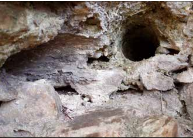
Figura 11. Detalle del núcleo de la muralla en el que se aprecian las huellas del entramado de vigas de madera.
