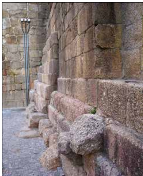
Figura 25. Sé de Viseu. Muro escalonado voltado à Praça D. Duarte.
