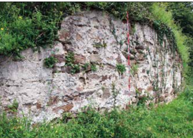
Figura 12. Paramento exterior del tramo sur de la muralla, en el que se conserva la huella del encofrado empleado en su construcción.
