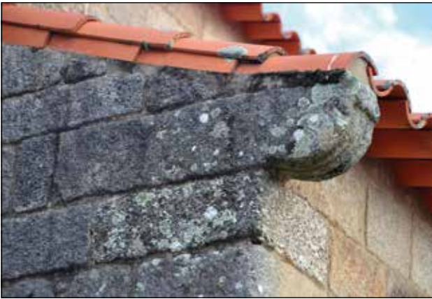
Figura 6. São Pedro de Lourosa. Modilhão estriado reaproveitado na reconstrução da igreja nos anos 30 do século XX.
