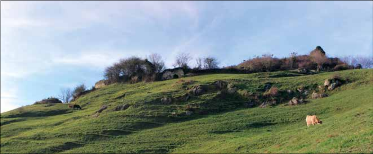
Figura 7. Vista panorámica desde el sureste de las estructuras del castillo: foso, muralla y torre.
