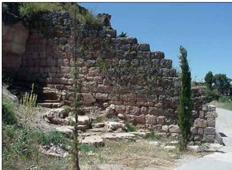
Figura 13. Coracha de grandes bloques de sillaría del castillo de Siurana, Cornudella de Montsant.
