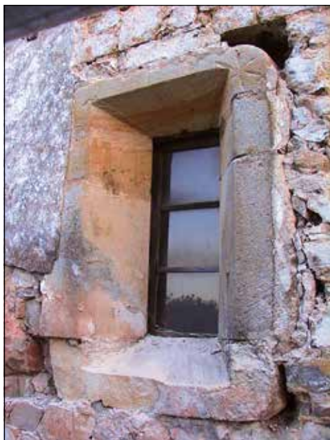
Figura 5. Ménsulas reutilizadas en la ventana del ábside barroco. Se aprecia el perfil acanalado y la hexapétala tallada en el lateral.
