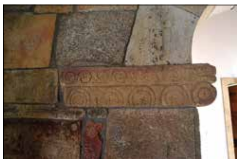
Figura 33. São Pedro de Balsemão. Imposta reaproveitada nas arcarias de separação entre naves na actual capela.
