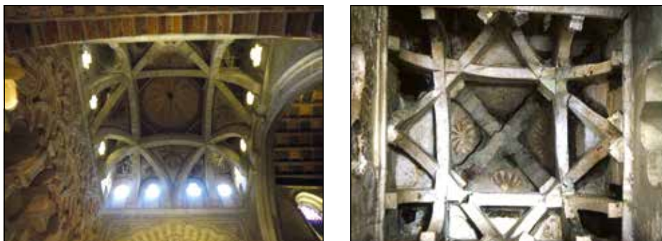
Figura 22. A. Bóvedas de crucería en la Mezquita de Córdoba; B. Bóvedas de crucería en Bab al-Mardum (Toledo) (Foto: MIT Libraries, Aga Khan Visual Archive).
