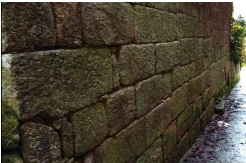
Figura 4. Muro sur de la capilla de San Brais de Vilaza. Fotografía de David Espinosa.
