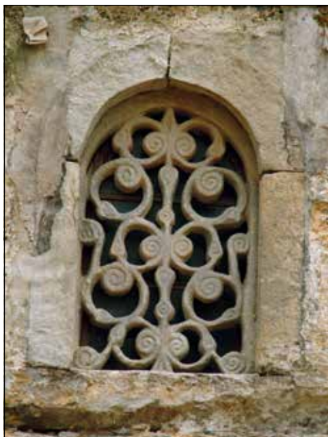
Figura 8. Celosía calada con tracería vegetal de inspiración andalusí.
