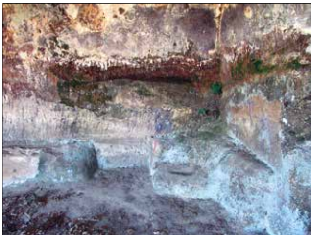
Figura 6. Nacimiento de plantas y de poiquilohídricos en el interior de la iglesia debido a los altos niveles de humedad.
