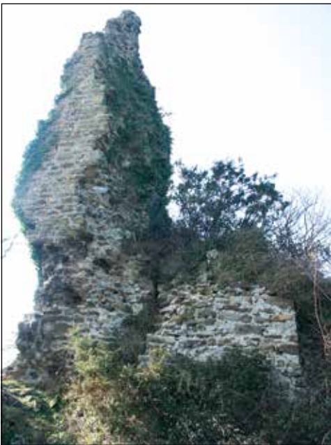
Figura 5. Detalle del paramento este del torreón central del castillo.
