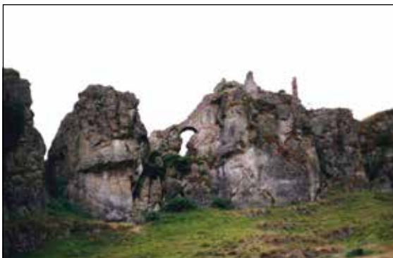
Figura 9. Detalle de las estructuras defensivas del castillo de Pancorbo, con obra de fábrica y también semirupreste. Fotografía del autor.
