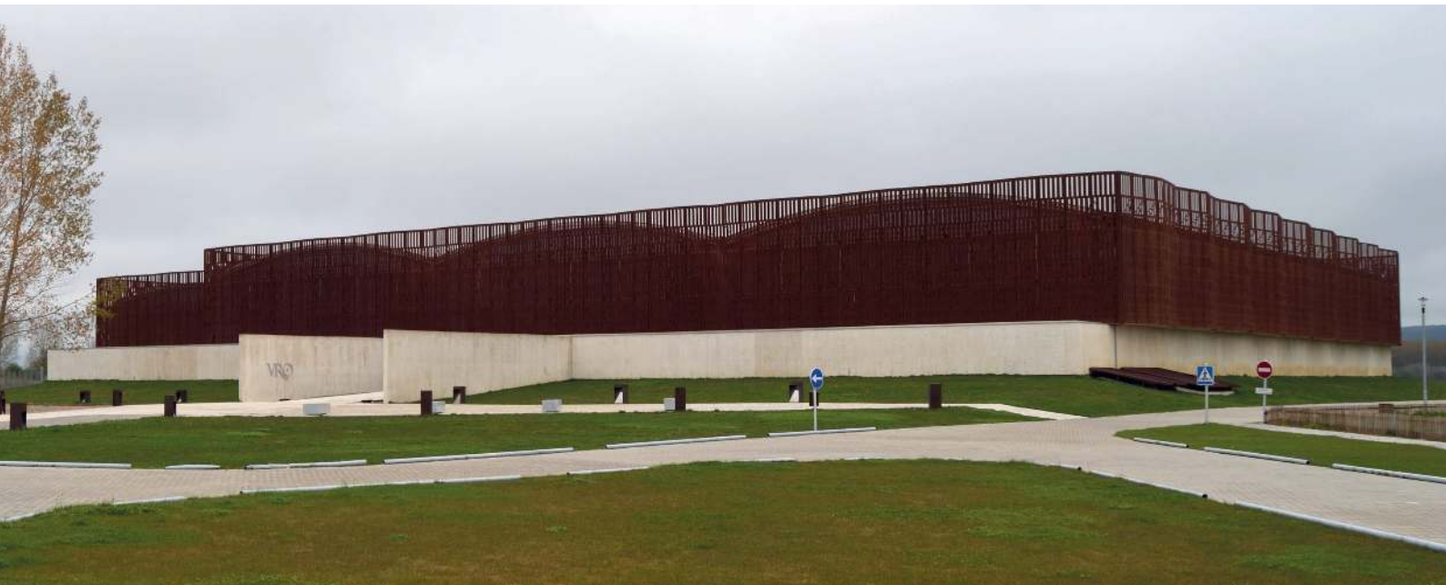
Fig. 4. Exterior del cerramiento de La Olmeda. Foto: Nailos.
