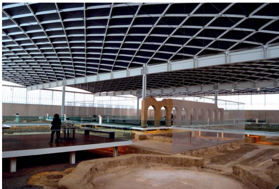
Fig. 5. Vista interior de la cubierta de la villa. Foto: Nailos.
