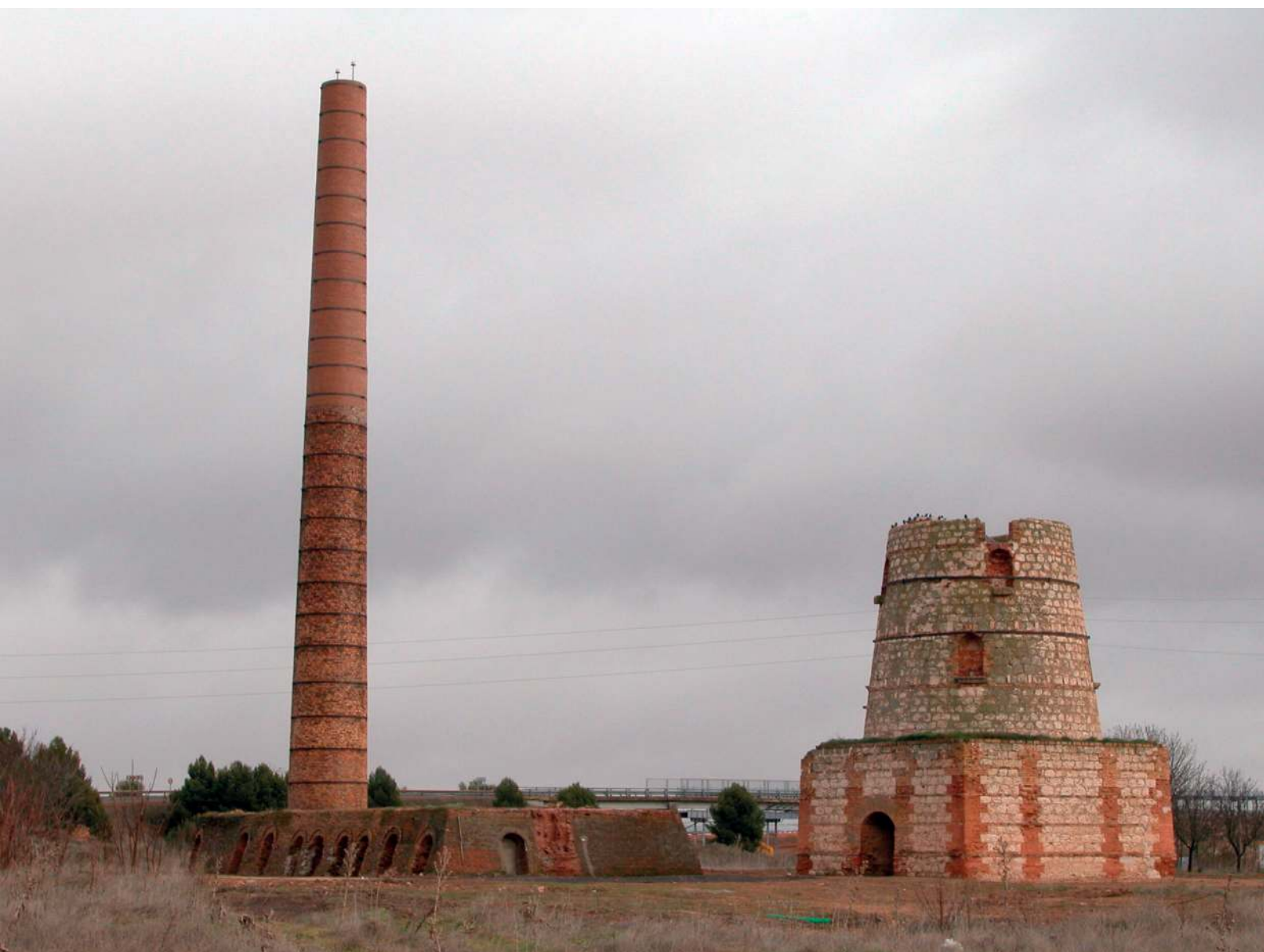
Fig. 31. Vista actual de los descontextualizados hornos principales de cemento y cerámica, con la chimenea reconstruida éste último. Los demás elementos del complejo fabril han desaparecido.
