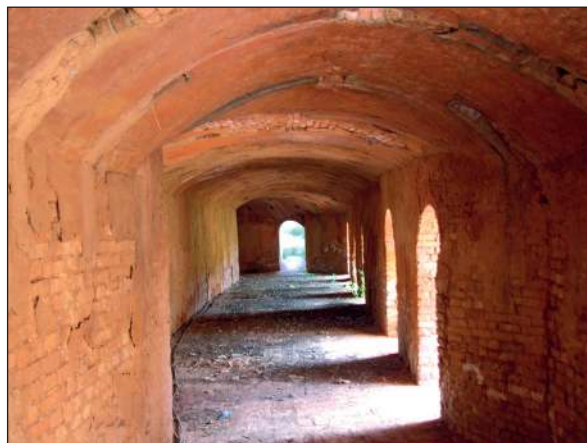
Fig. 10. Interior de la galería lateral del horno principal de cerámica, con accesos laterales (a la derecha de la imagen) y cámara del horno cerrada (a la izquierda de la imagen).
