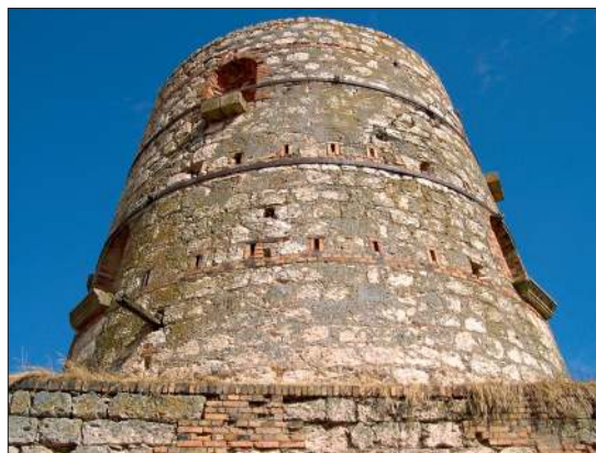
Fig. 13. Chimenea del horno de cemento principal.
