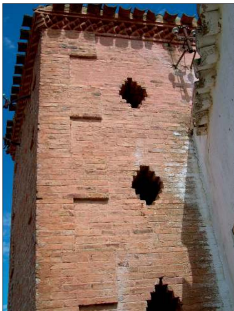
Fig. 22. Transformador de la Fábrica de Cerámica. Derribado.
