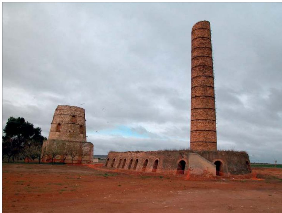
Fig. 30. Vista general del complejo industrial tras la demolición, a la cual sobrevivieron únicamente los hornos principales de cemento y cerámica (parcialmente). Imagen tomada en 2005.
