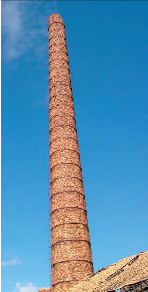
Fig. 6. Chimenea original del horno principal de cerámica antes de su demolición.
