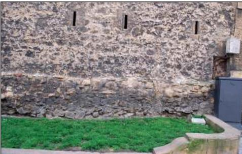
Figura 25. Fachada norte del monasterio de san Pelayo en la calle Jovellanos. Zapata de cimentación de la ampliación de fines del XVII.
