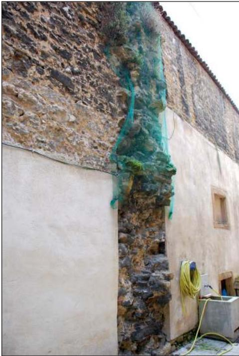
Figura 12. Enjarje del muro demolido que componía la esquina suroeste del claustro de San Vicente.
