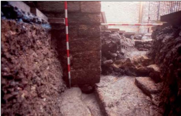
Figura 33. Cimentación del muro oeste de la Torre Vieja.
