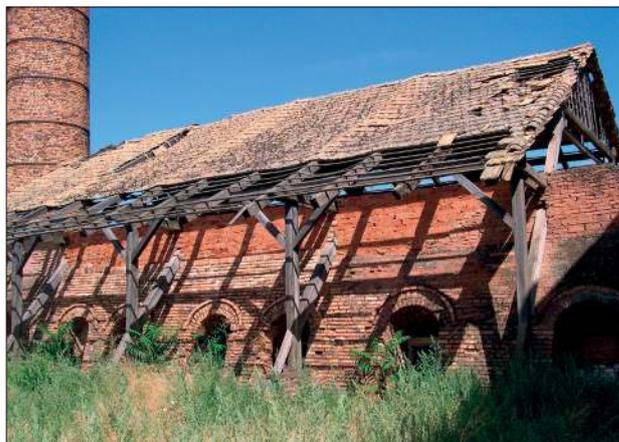
Fig. 9. Exterior del horno principal de cerámica. La cubierta con estructura de madera y tejada fue desmontada.
