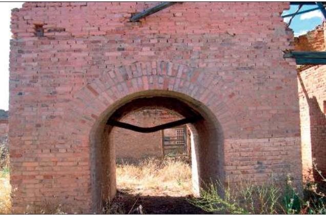
Fig. 14. Cuerpo inferior del horno de cemento principal.
