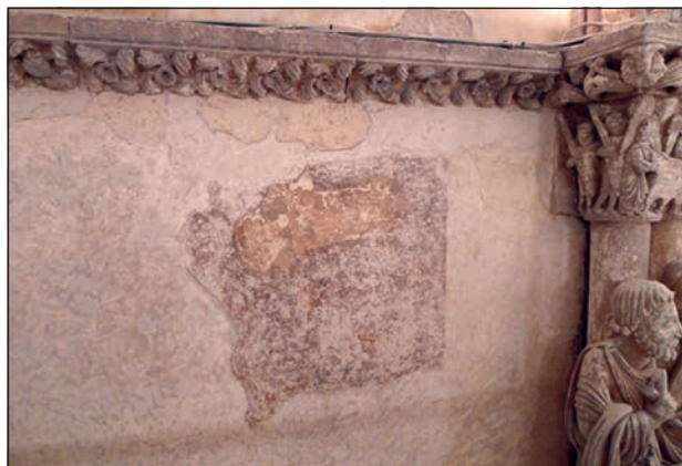
Figura 49. Obsérvense perfilados ligeramente rehundidos los morteros repuestos que marcan el contorno de los guarnecidos que se salvaron de la destrucción.
