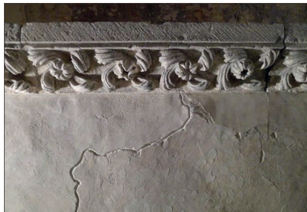
Figura 52. Aspecto de las superficies después de la limpieza.
