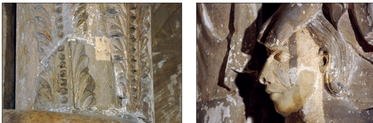
Figura 45. Pruebas de limpieza láser sobre soporte pétreo, reintegrado con piedra (izquierda) y con mortero (derecha).
