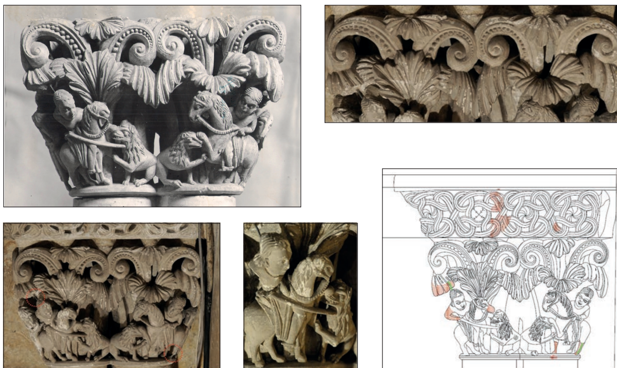
Figura 47. En esta fotografía del capitel situado sobre las imágenes de Santo Tomás y San Bartolomé, podemos observar, enmarcado con líneas discontinuas de color rojo, las únicas varillas de cobre que no se cubrieron con morteros de reintegración.
