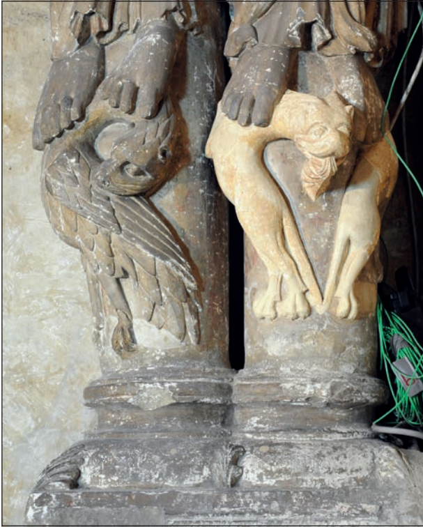
Figura 46. Cata de limpieza láser y aspecto final sobre piedra de Laspra de los fustes de uno de los grupos escultóricos. Este tipo de limpieza permite eliminar el ennegrecimiento superficial, preservando la pátina marfileña y los restos de pintura.
