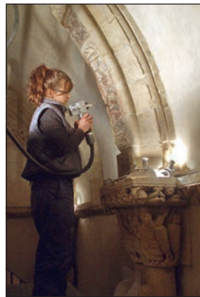
Figura 51. Labores de limpieza láser.
