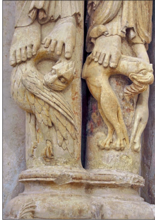
Figura 46. Cata de limpieza láser y aspecto final sobre piedra de Laspra de los fustes de uno de los grupos escultóricos. Este tipo de limpieza permite eliminar el ennegrecimiento superficial, preservando la pátina marfileña y los restos de pintura.
