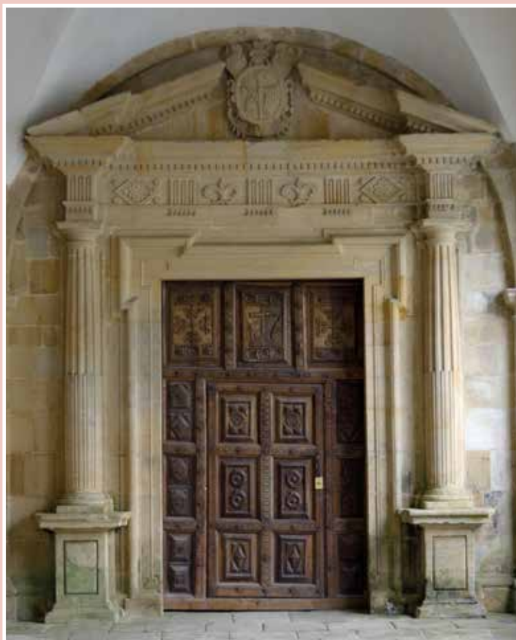
Escudo 16. Santa María de Valdediós. Puerta de acceso al claustro coronada con el escudo del Cister.
