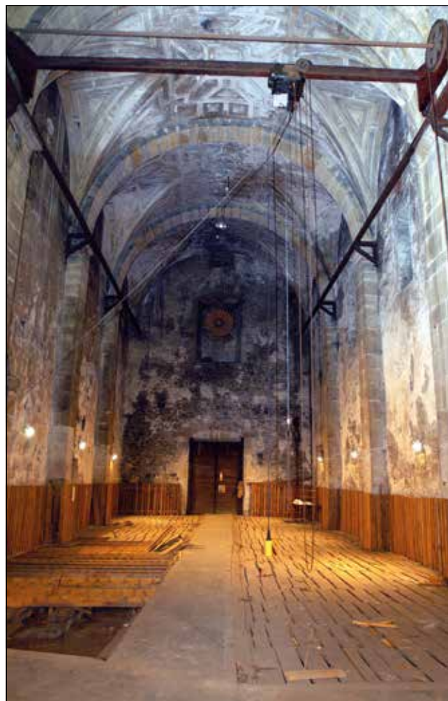
Figura 2. Nave central de la iglesia convertida en almacén de tabaco.
