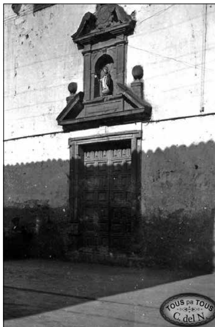
Figura 3. Portada de acceso a la iglesia abierta a la calle Mayor. Fuente: www.touspatous.es .
