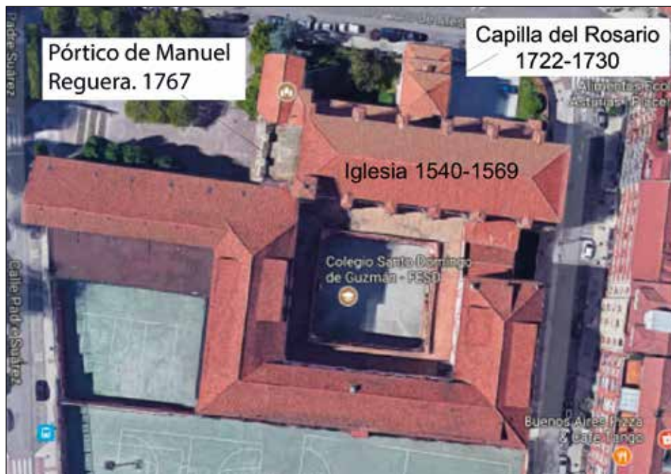
Figura 1. Fotografía aérea de la planta actual.
