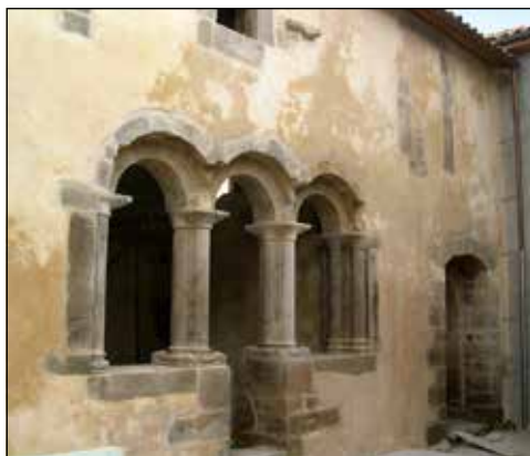
Figura 5. Arquería de la sala capitular. El capítulo fue construido a principios del siglo XV, de forma que su muro oeste constituye un mismo paño con el imafrente de la iglesia y el palacio de los González de Oviedo.
