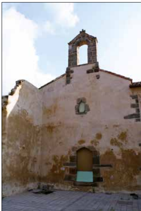
Figura 4. Imafrente de la iglesia conventual visto desde el antiguo claustro.
