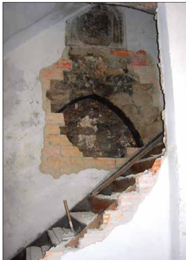
Figura 7. Fachada del palacio franciscano del siglo XV, localizada tras el tabique de ladrillos que la ocultaba.
