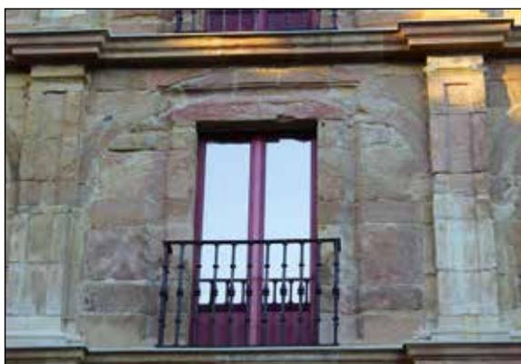
Figura 12. Alzado interior de la crujía que originalmente se situaba en el lado este del claustro y que con la intervención de Ignacio Álvarez Castelao se remontó en el lado norte. Se aprecian las huellas de los arcos rebajados originales del diseño de Moñiz Somonte. Detalle de uno de los vanos.
