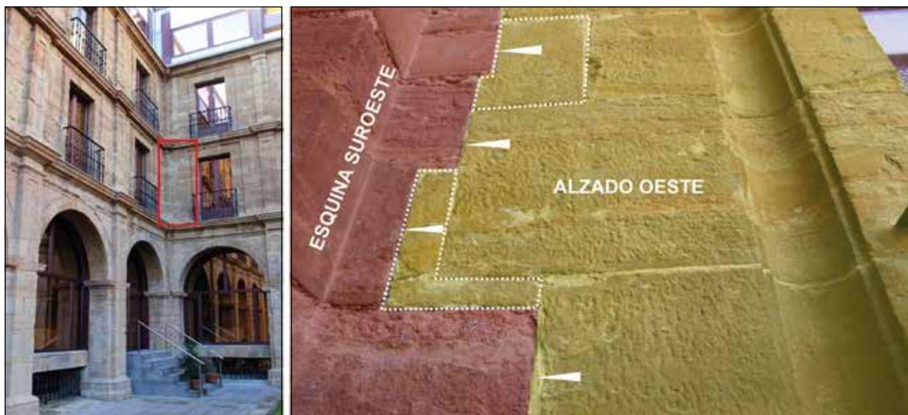
Figura 11. Detalle de la esquina suroccidental del claustro. Se observa como el lienzo occidental (en amarillo) se adosa a la esquina suroeste, que presenta uniformidad constructiva con el alzado sur (en rojo). Se aprecia la adaptación a los huecos resultantes en la talla de los sillares que sirven de unión (en línea de puntos).
