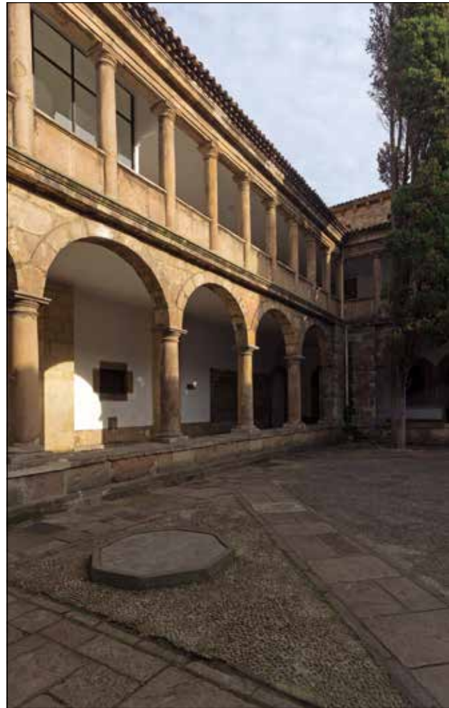
Figura 5. Claustro. Estado actual.
