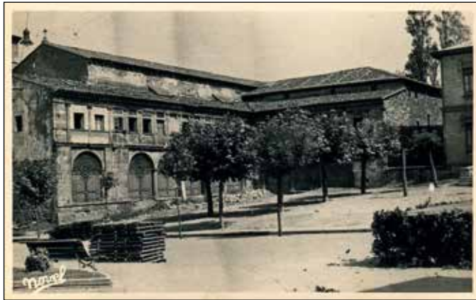
Figura 6. Claustro. Estado previo a las obras de 1958-1965. Fotografía: Archivo personal de Ángel Garralda.
