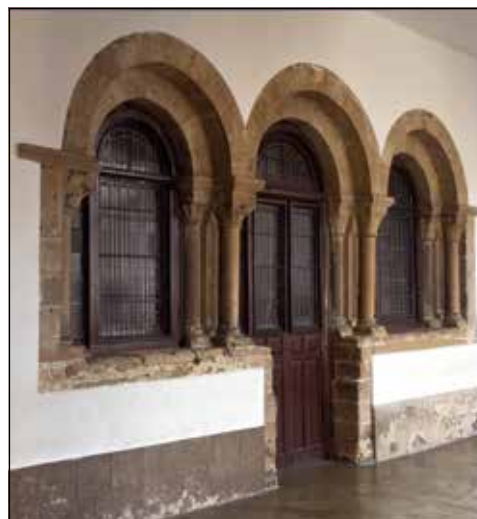
Figura 2. Arquería del paño oriental del claustro.
