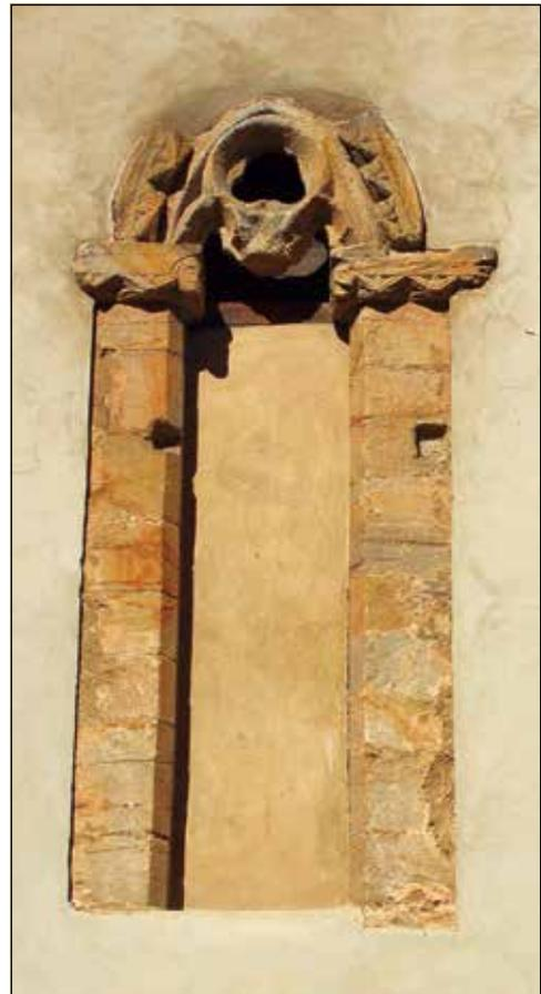
Figura 4. Ventana en el muro sureste de la iglesia. Se aprecian dos entalles en las jambas para el asiento del techo del corredor del claustro. La falta del remate superior del arco también puede estar en relación con la sujeción de la cubierta del mismo.
