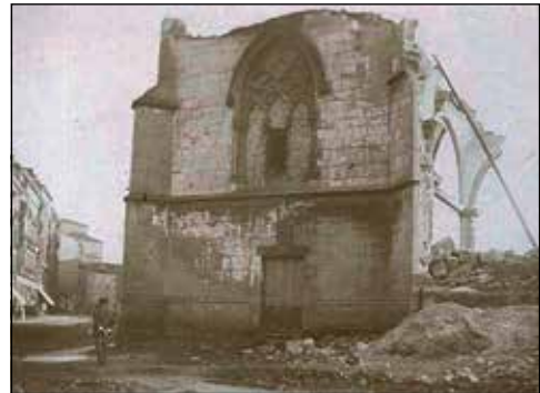
Figura 3. Proceso de demolición de la capilla de los Argüelles. Colección de Fermín Canella Secades, depositada en la Biblioteca de Asturias. Fondo Tolivar-Alas, Signatura: Ast T.A. Can Fot 1-49 (accesible en http://bvpb.mcu.es/fototeca/es/consulta/registro.cmd?id=489359 ) [Consultado: 05.12.2016]
