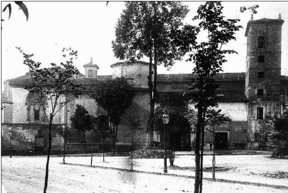
Figura 14. Vista del lateral norte de la iglesia de San Francisco, con la capilla de los Argüelles en el extremo izquierdo de la imagen y la torre campanario a la derecha. Entre ambas estructuras se sitúan la capilla de los Remedios, rematada por linterna, y la de la Misericordia o San Antonio, con cimborrio octogonal. Fotografía de 1895 de Luis Muñiz Miranda, publicada el 24 de febrero de 2016 en la página de Facebook de "T Oviedo" ( www.facebook.com/toviedoES )
