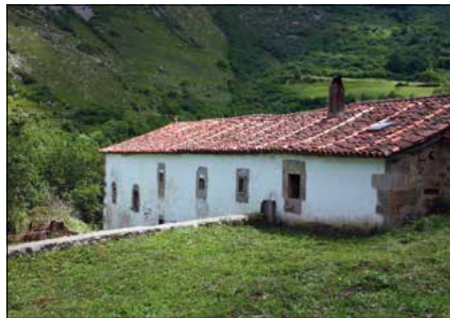
Figura 8. Edificio que pudo corresponder a la «panera» del monasterio de las Huelgas de Avilés documentada en 1710. (Fot. F. Miguel Hernández).
