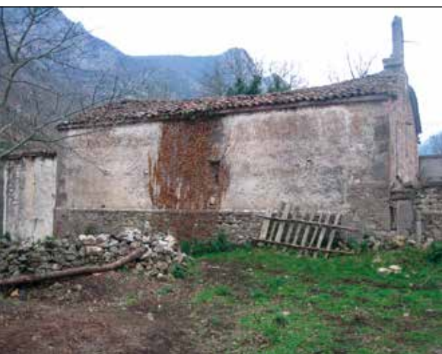
Figura 3. Muro norte de la iglesia (Fot. F. Miguel Hernández).
