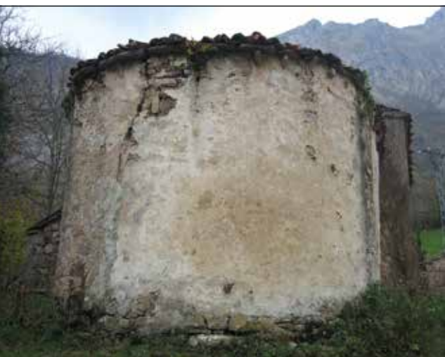
Figura 2. Ábside semicircular de la iglesia, atribuible al románico, s. XIII (Fot. Miguel Cimadevilla Gutiérrez).
