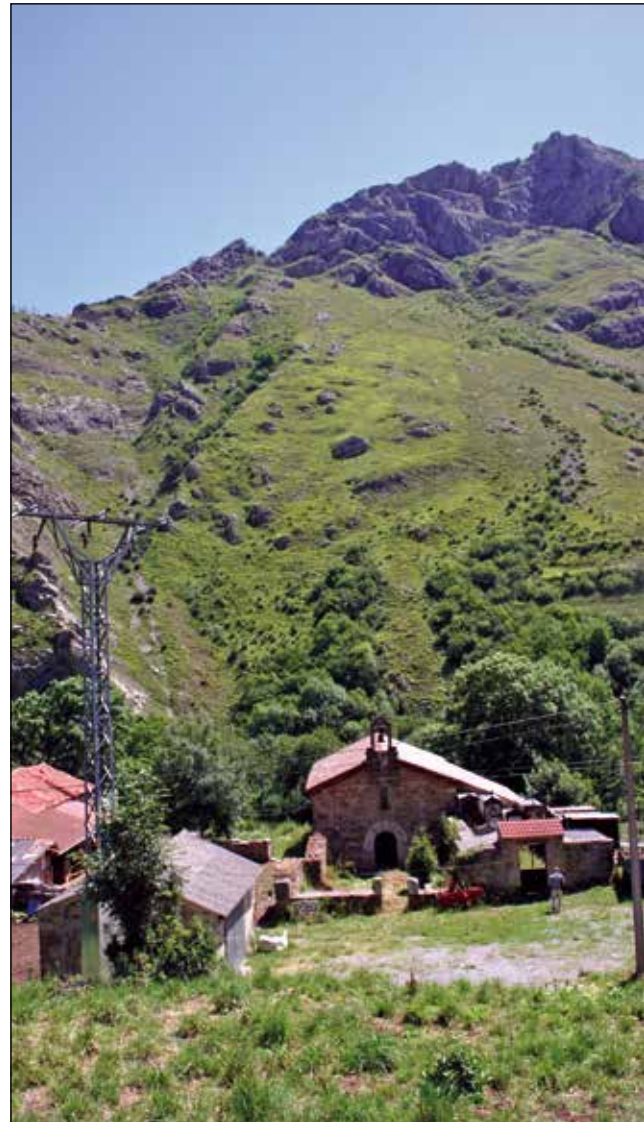
Figura 1. Emplazamiento de los posibles restos del monasterio de Gúa: de frente, iglesia y a la izquierda, antiguo edificio, quizás vieja casa rectoral (Fot. F. Miguel Hernández).
