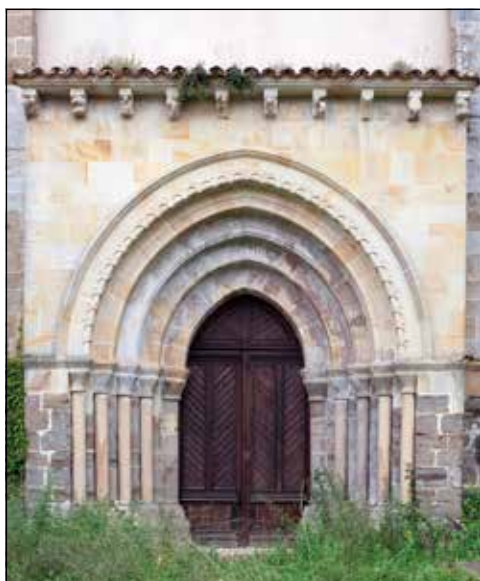
Figura 6. Portada oeste. Estado actual.
