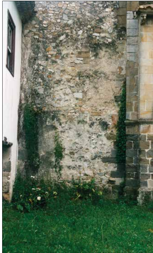
Figura 14. Antigua puerta de acceso al coro vista desde el exterior.
