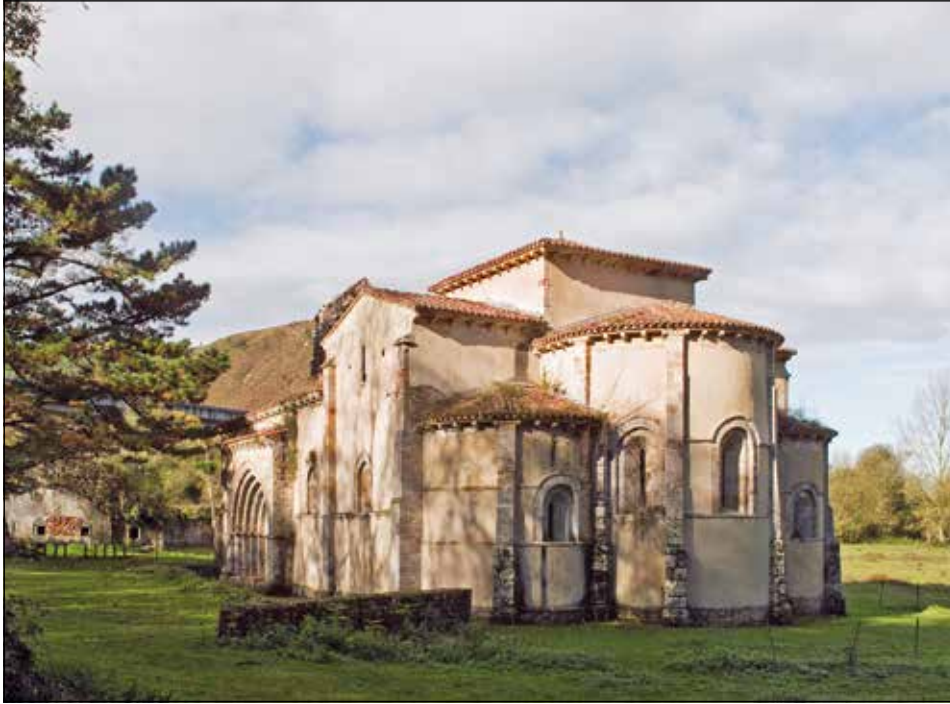
Figura 4. Vista general de la iglesia desde el sureste.
