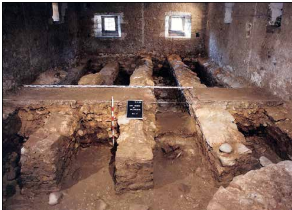
Figura 8. Vista general de los muretes que sostienen el solado del granero construido en 1777 sobre las estructuras altomedievales. Fotografía Otilia Requejo.
