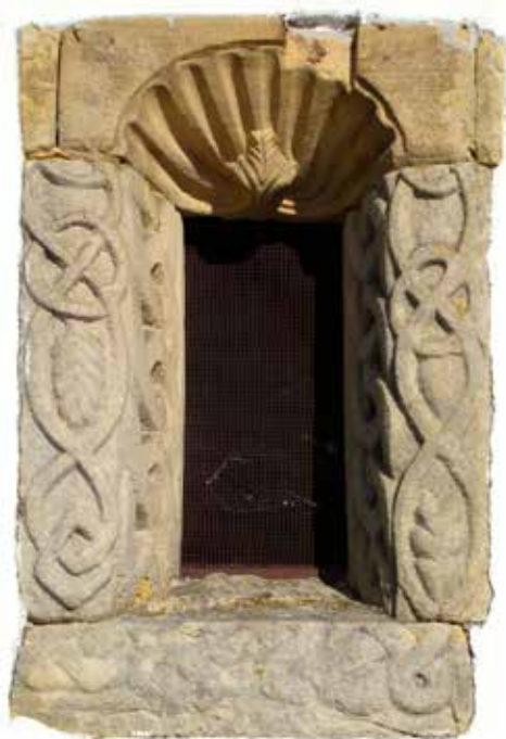
Figura 5. Las jambas y alféizar de esta ventana de la capilla del cementerio parroquial se construyeron con los restos del arcosolio conservado en la iglesia monasterial hasta el siglo XIX.
