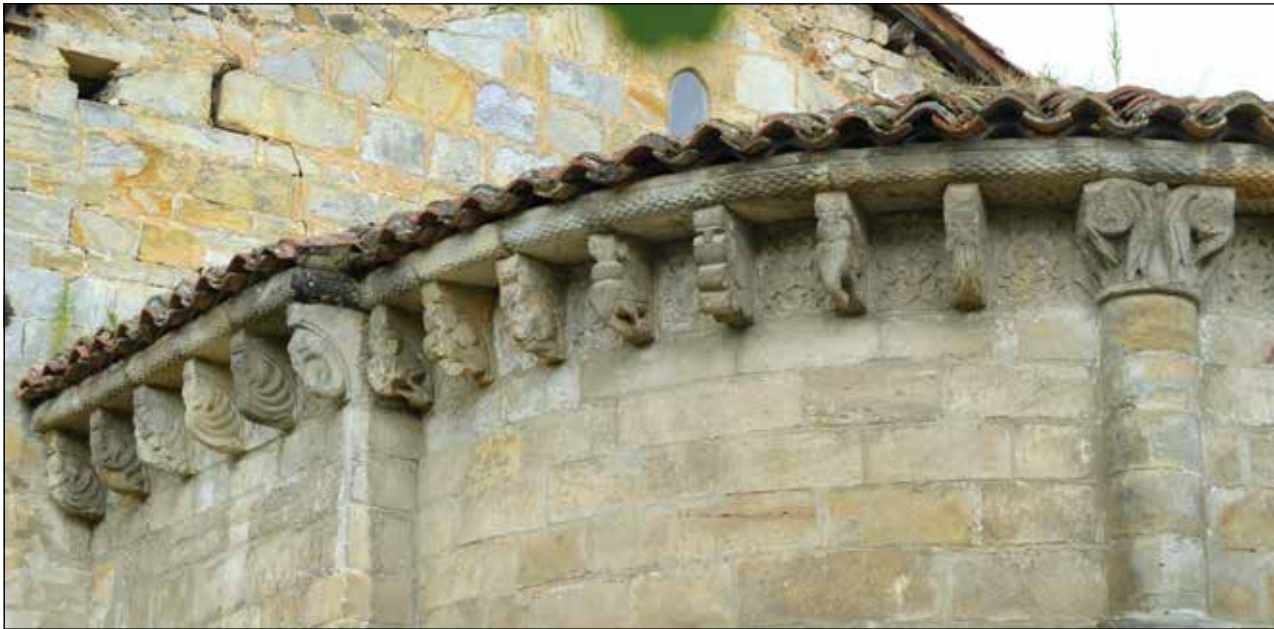
Figura 14. Detalle de los canecillos del ábside de la iglesia.
