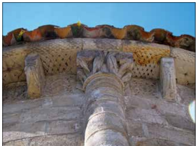
Figura 16. Detalle del friso del alero del ábside.
