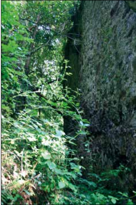
Figura 8. Posible muro de la cabecera de la iglesia moderna de Belmonte.
