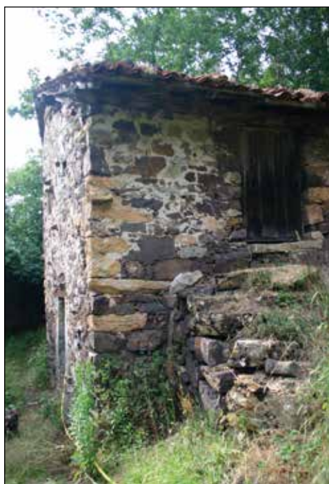
Figura 5b. Posible casa del hortelano integrada en la nueva cerca.
