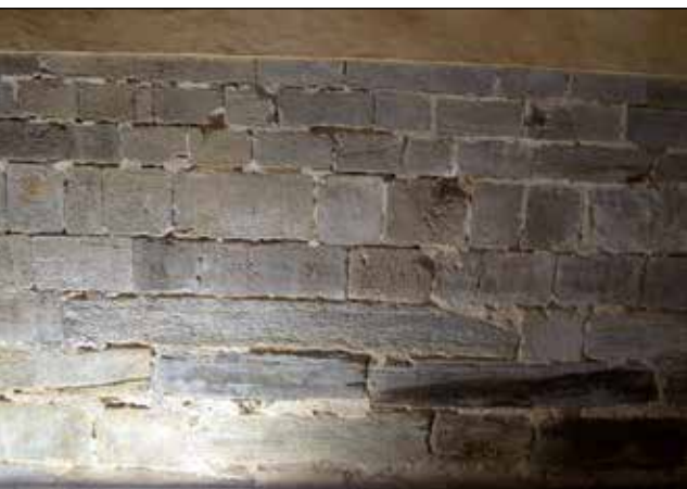
Figura 5. Vista del alzado interior del cerramiento meridional del templo. Se aprecian tres fábricas superpuestas: la inferior con aparejo de bloques alargados; la intermedia con sillería y numerosas marcas de cantero; y la superior, revocada, con fábrica de mampostería.
