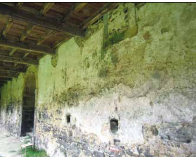
Figura 17. Panda norte del claustro, con sendas entradas y escaleras de acceso al sobreclaustro y al templo. En primer término se aprecia una ventana amortizada por el forjado del claustro barroco.
