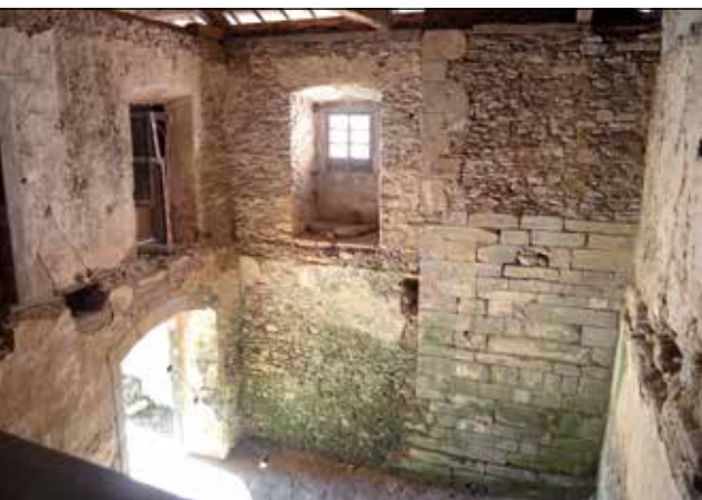
Figura 6. Esquina sudoeste del templo, en la que se aprecian diferentes fábricas superpuestas. Hacia el oeste (a la izquierda de la imagen) se le adosa la obra de la nueva portería y de la casa abacial del siglo XVII.
