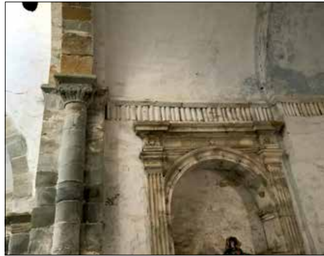
Figura 3. Vista interior de la capilla mayor de la cabecera. Se aprecia como el arco de triunfo (Obona III) se adosa al friso de baquetones anterior (Obona II).
