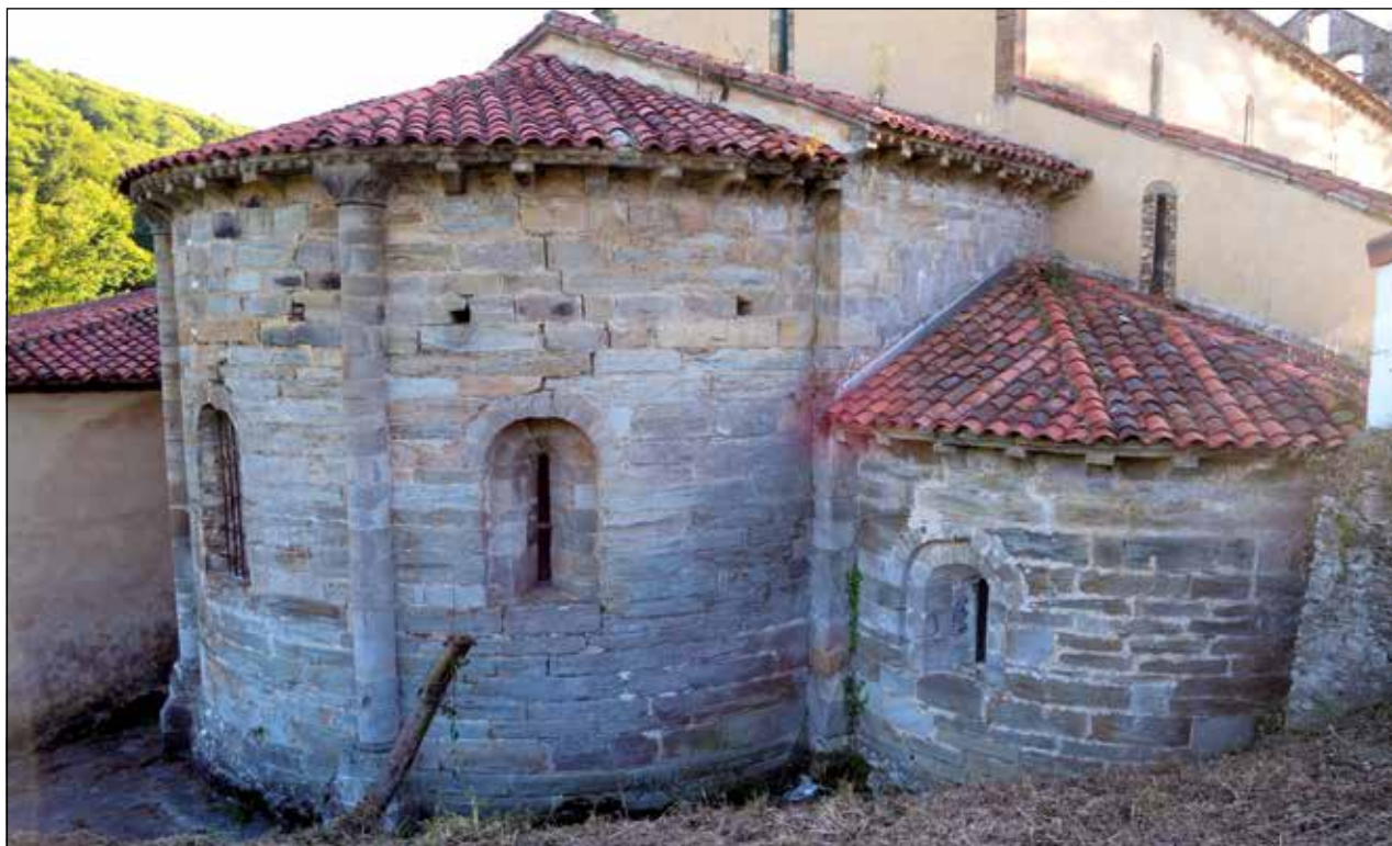
Figura 2. Vista exterior del triple ábside escalonado del templo románico. Se aprecian dos fábricas: la inferior, de bloques alargados y fechada entre 1113 y 1126; la superior, a la que corresponde el aparejo de sillería, la cornisa con bolas y las semicolumnas adosadas, con una cronología de la segunda mitad del siglo XII.
