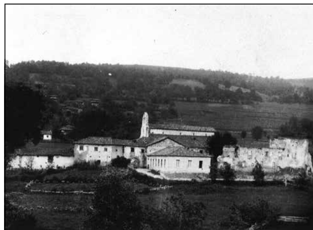
Figura 13. Antigua fotografía del conjunto monástico desde el sudoeste. Se aprecia todavía en pie parcialmente la panda meridional, y la torre que remataba la esquina sudeste del recinto claustroal. Del otro lado del claustro, en la panda occidental, se localizan las escuelas públicas construidas en 1895 (Llaca 1999:182).
