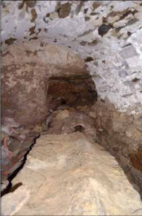
Figura 15. Interior del aljibe situado en la panda septentrional del claustro. Se aprecia la reforma de este espacio hidráulico mediante la instalación de un encañado cerámico.
