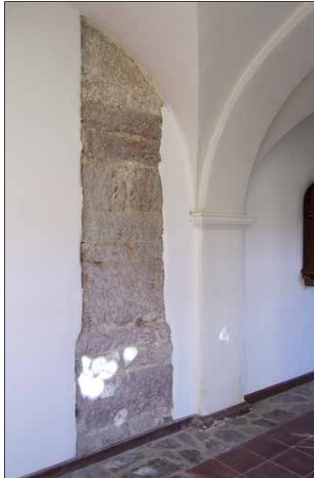
Figura 23. En la fotografía se aprecia la demolición de uno de los contrafuertes del templo (c. 1679) para construir la galería norte del claustro (c. 1697). Fotografía de los autores.
