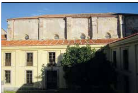
Figura 11. Vista desde el sur del alzado meridional de la nave del templo, recorrido por 5 contrafuertes que se corresponden con otros tantos arcos fajones que soportan la bóveda de cañón interior. Fotografía de los autores.
