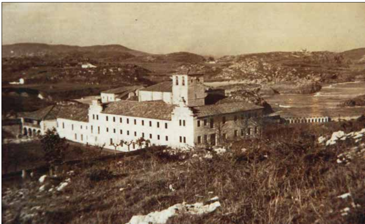
Figura 24. Edificio construido por la Compañía de Jesús a partir de 1919, y que fue demolido y reedificado en 1973-1977. Fotografía posiblemente anterior a la exclaustración de 1932. Archivo de la Compañía de Jesús.
