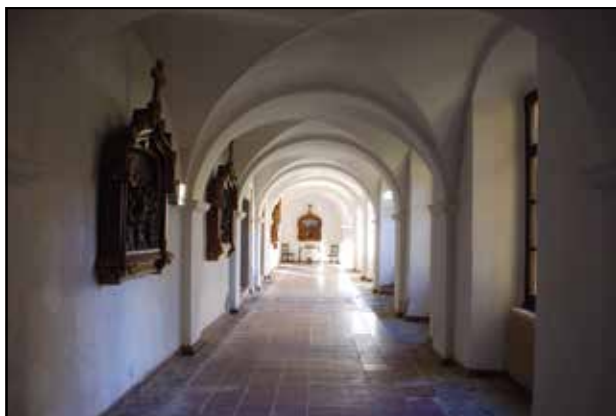
Figura 19. Galería de la planta baja de la crujía occidental del claustro, configurada por cinco tramos de bóveda de arista. Fotografía de los autores.
