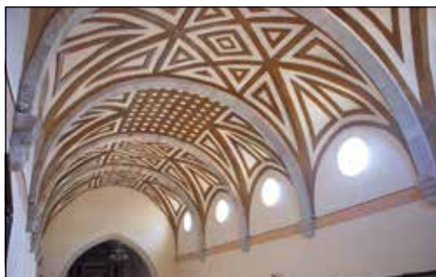
Figura 10. Bóveda de cañón con lunetos sobre la nave de la iglesia. Corresponde a la obra de la iglesia de 1679. Fotografía de los autores.
