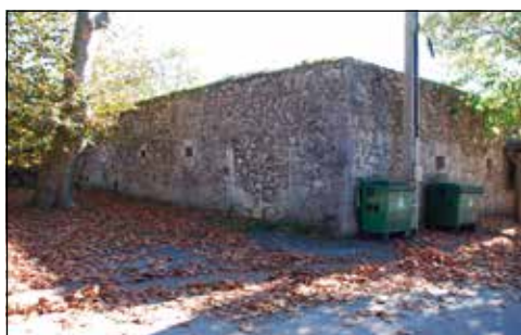
Figura 17. Vestigios del cuerpo adelantado de la edificación localizada al sudoeste del patio de servicio. Por su ubicación, definiendo un compás de entrada al patio de servicio, pudo albergar una parte de los almacenes monásticos, algunos espacios productivos o incluso la cárcel abacial. Fotografía de los autores.
