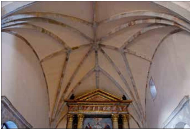
Figura 6. Bóveda estrellada que cubre la cabecera del templo, construida entre 1548 y 1550. Fotografía de los autores.
