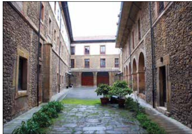
Figura 12. Crujía residencial interior. 1694-1700. Fotografía: César García de Castro Valdés.
