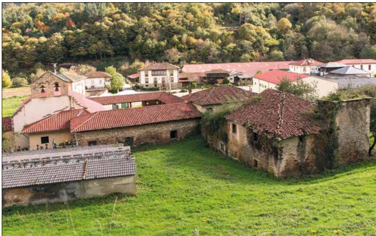
Figura 12. Conjunto monástico desde el oeste. A la izquierda puede verse la crujía de orientación este-oeste del conjunto residencial, con su gran chimenea en el extremo occidental. Foto: los autores
