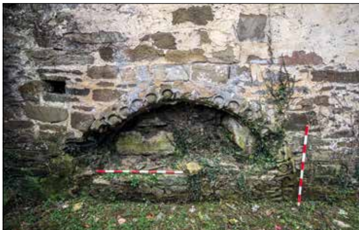
Figura 8. Arcosolio de la fachada norte de la nave. Foto: los autores
