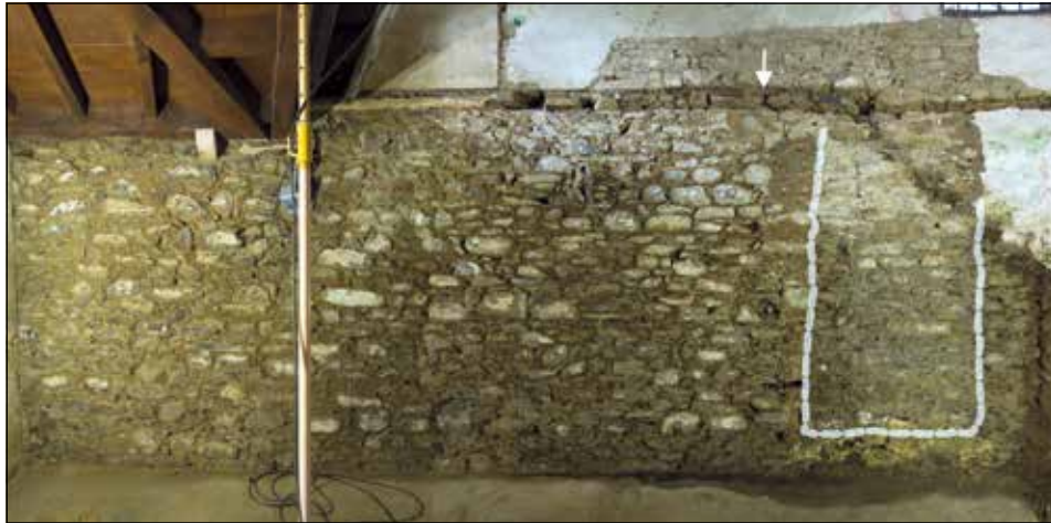
Figura 9. Pared norte del cabildo occidental. En línea discontinua, la antigua puerta de acceso hoy cegada. La flecha señala el nivel exterior del terreno en la actualidad. Foto: los autores
