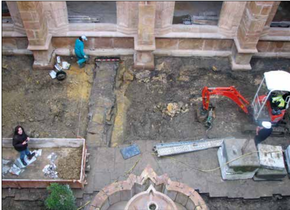
Figura 8. Canalización de lajas (C2).
