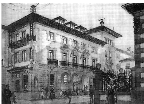
Figura 4a-b. Caserón antiguo de San Vicente a finales del siglo XIX ( Oviedo en el Recuerdo , 1992) y edificio de la Casa de Correos y Telégrafos proyectado en 1921 por Luis Menéndez Pidal y Fernando Arzaduna.
