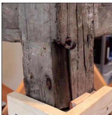
Figura 7. Una de las dos armellas de hierro ubicadas en las patas traseras.
