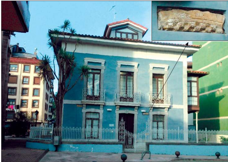
Figura 8. Aspecto de la casa rectoral de Grado y detalle de una de las piezas románicas insertas en su fachada.
