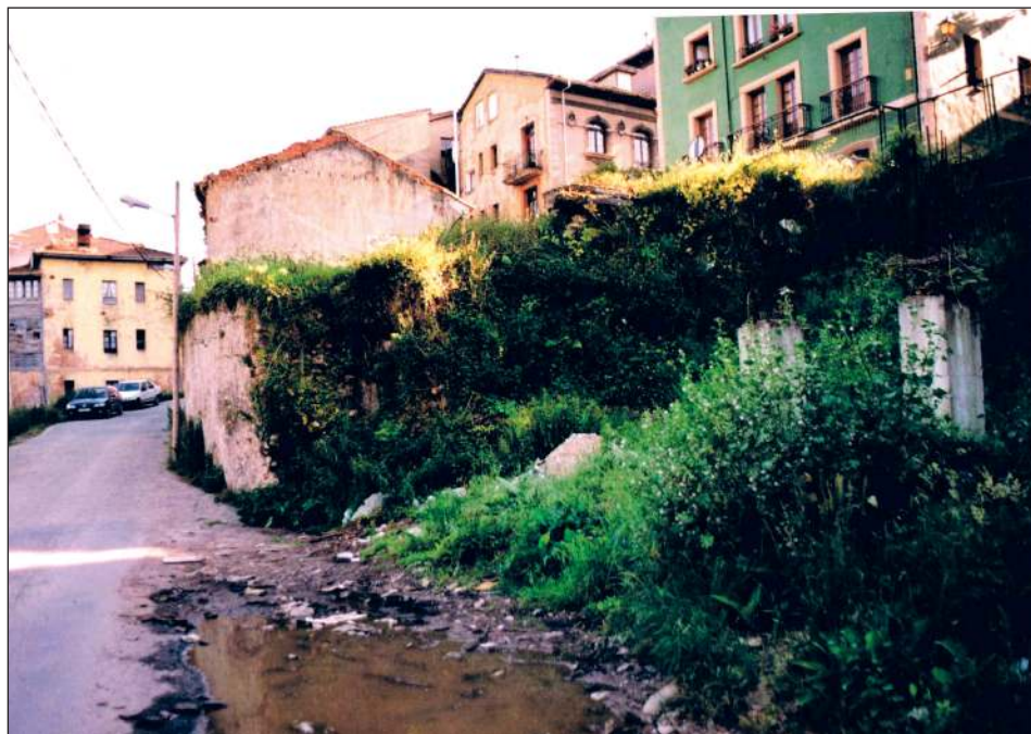
Figura 9. Aspecto de la calle Tras el Ayuntamiento vista desde el norte en una imagen tomada en el año 2002. A la derecha, en primer término, se observa el solar y pilares de hormigón del armazón del edificio. Al frente la sección de la muralla y el talud sur del solar.
