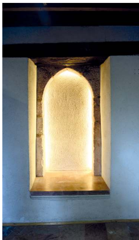
Figura 18. Imagen del paramento interior donde se conserva el arco de la torre antigua.
