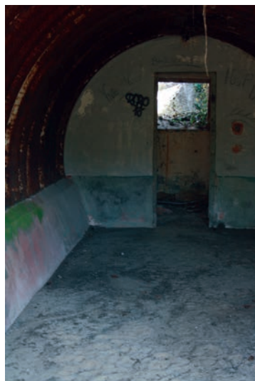
Figura 15. Ejemplares de abrigos de chapa. 15a: restos del abrigo para personal de Klara donde es claramente visible la forma en arco de la estructura, también se puede apreciar el perfil constructivo del mismo. 15b: otro refugio de la misma tipología perteneciente a otra posición en Ré, vista desde la entrada. 15c: imagen del mismo abrigo en esta ocasión desde la parte posterior, se aprecia como los constructores intentaron darle una apariencia de vivienda, al dotar el acceso a la estructura de una puerta y ventana, además de tener un friso pintado a lo largo de sus muros (fotografías autor).
