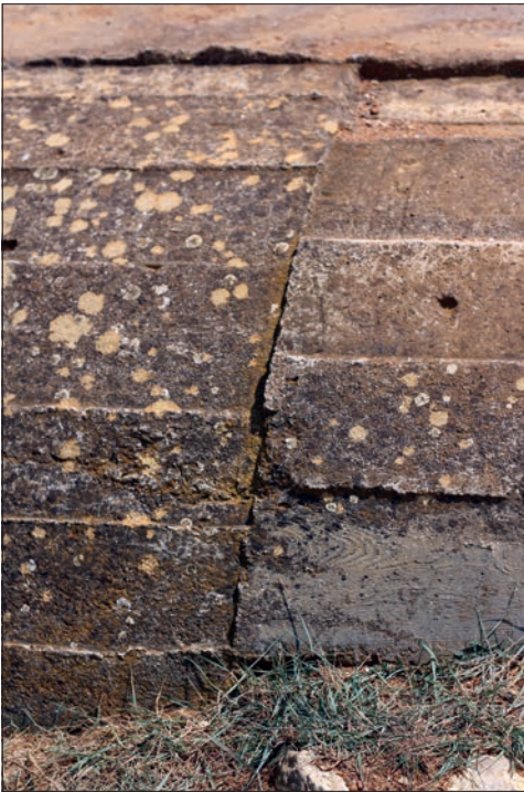
Figura 18. Ejemplo del trabajo de encofrado en una de las obras de la posición Rabe . Se puede apreciar el diferente solape en las tablas de madera empleadas en dar forma curva a uno de los muros de la construcción. En su parte inferior derecha, es visible la marca dejada por el nudo de la madera en el hormigón (fotografía autor).
