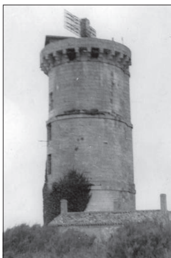
Figura 7. Posición Kathi . 7a: Fotografía aérea del año 1946, donde se pueden ver los emplazamientos de radar. Uno en las proximidades de la playa, con el equipo Würzburg , y sobre la estructura del viejo faro, el segundo equipo (SHM Rochefort 1W 1849). 7b: imagen del antiguo faro de Baleines, en su parte superior se aprecia la antena del aparato de radar Seetakt (SHM Rochefort 1W 1849). 7c: la misma construcción en la actualidad, donde han desaparecido los restos de dicho material (fotografía autor).
