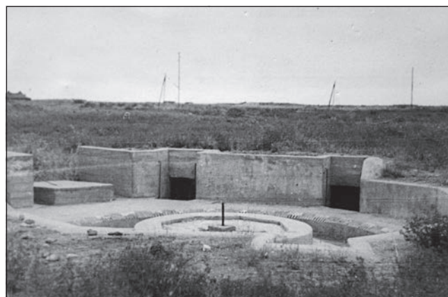
Figura 30. Uno de los emplazamientos a barbata de la batería Schwalbe en Oléron. Se aprecian los mejores detalles constructivos respecto a la obra anterior, así como la presencia de los nichos en los laterales del mismo (SHM Rochefort 1W 1849).
