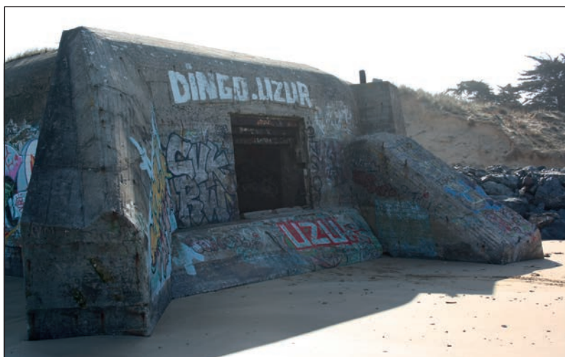
Figura 37. Vista de la misma construcción poco antes de ser demolida. Son visibles los muros de flanqueo que incrementaban la protección, pero limitaban el sector de tiro de la pieza (fotografía autor).
