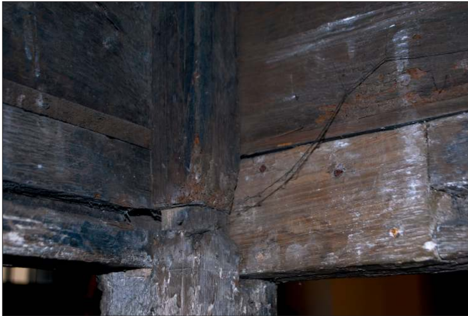
Figura 8. Detalle de reparación en larguero inferior. Foto: César García de Castro Valdés.
