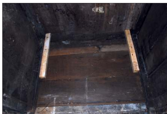
Figura 4. Interior. Al fondo, panel izquierdo. Se observa la sujeción de la tapa mediante cuadradillos reutilizados colocados tras la reconstrucción post 1934. Foto: César García de Castro Valdés.
