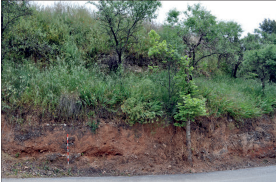
Figura 5. Estado original del talud antes de iniciar el sondeo 29.000. Fotografía desde el oeste por G. García-Contreras Ruiz incluida en García-Contreras y Moreno (2016).
