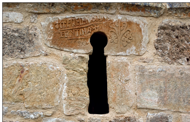
Figura 9. Valdeleiteja de Siero. Aspillera del muro testero.
