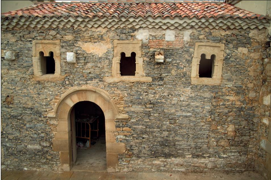
Figura 9. El muro sur de la iglesia en una imagen correspondiente a la fase de restauración. Una vez desmontado el pórtico y con el paramento visto se aprecian las roturas producidas por la portada románica y el ábside barroco.
