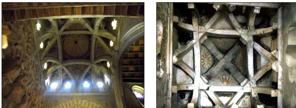
Figura 22. A. Bóvedas de crucería en la Mezquita de Córdoba; B. Bóvedas de crucería en Bab al-Mardum (Toledo) (Foto: MIT Librairies, Aga Khan Visual Archive).
