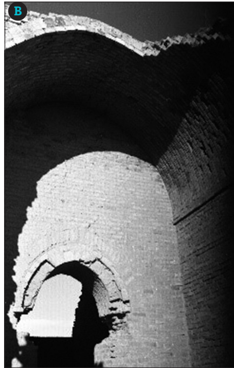
Figura 23. A. Patio interior de Qasr al-Tuba, (Foto disponible en: http://static.panoramio.com/photos/original/35293553.jpg ). B. Puerta lateral de entrada a las dependencias residenciales con bóveda de cañón hecha de ladrillo. R71-022, (Foto: C. Ewert). C. Khirbat al-Mafjar, Reconstrucción de la fachada del porche de la casa de baños en Khirbat al-Mafjar (Hamilton 1988: fig. 5).
