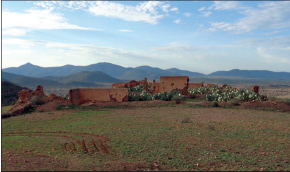
Figura 9. Vista general del puesto de Taguenza, desde el sureste
