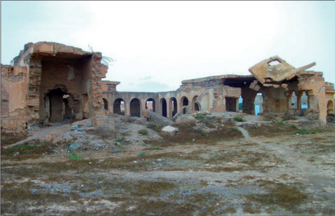
Figura 15. Ruinas de la edificación principal de Tiliuin, desde el noreste
