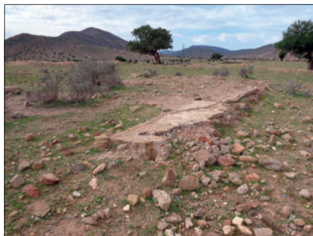
Figura 5. Detalle de los restos de la construcción interior del destacamento de Bifurna, desde el noreste
